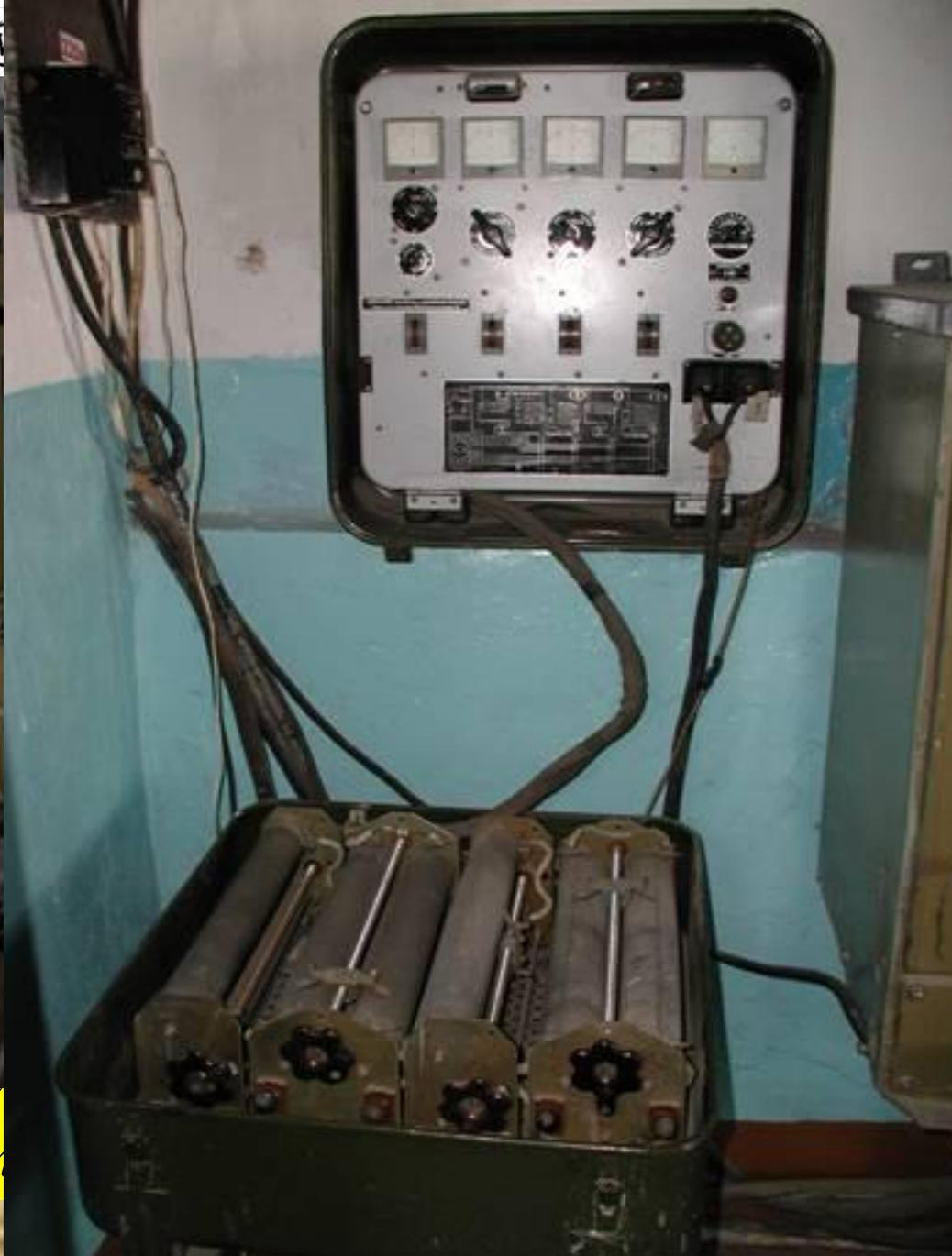
*Рис. 1. Вид сзади панели «Сигнал»; 1 – батарея; 2 – группа переключателей; 3 – преобразователь; 4 – индикатор; 5 – аккумулятор; 6 – аккумулятор*
