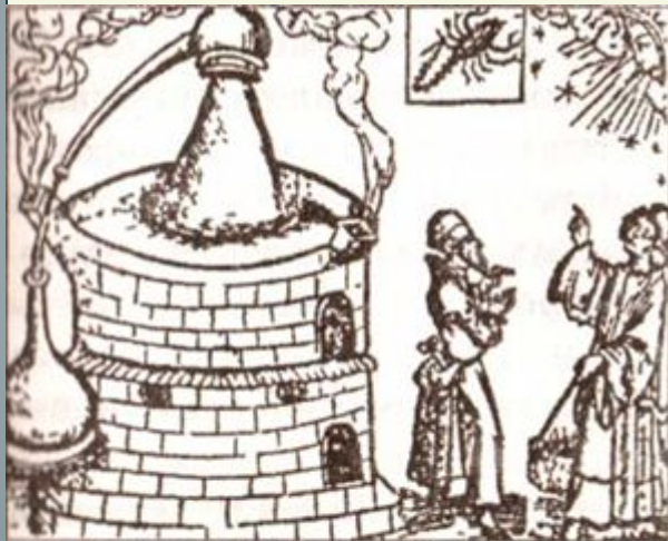
Печь для дистилляции (из сочинения Гебера)
