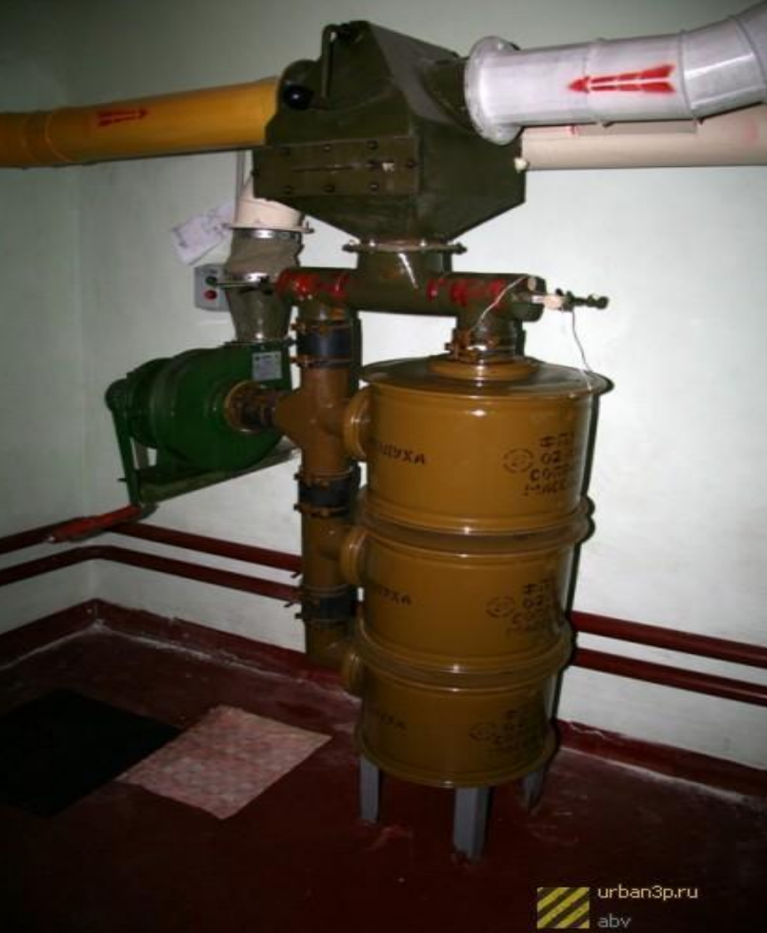
Фильтровентиляционный агрегат.
