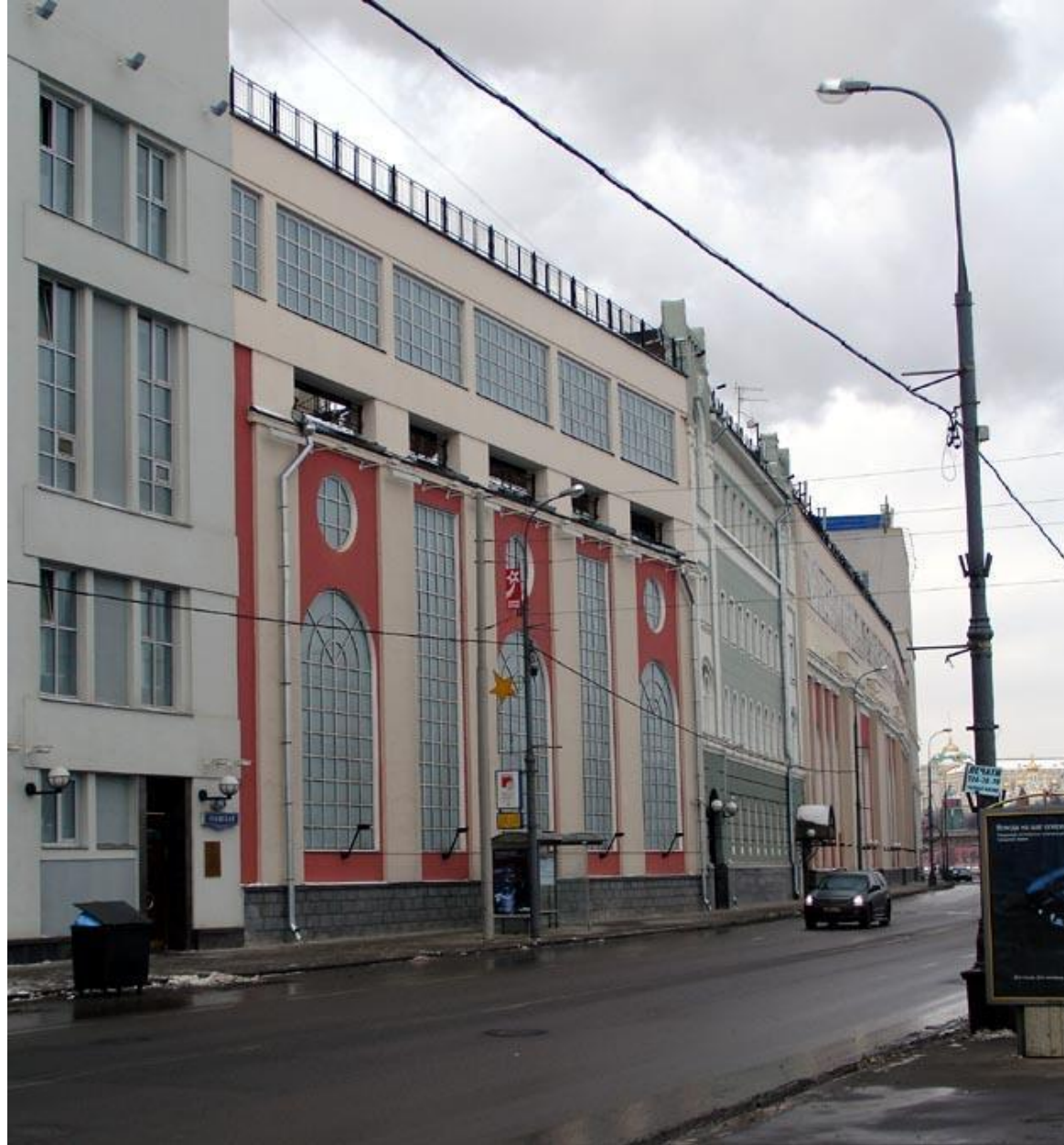
Центральная тепловая электростанция МОГЭС на Раушской набережной. 1927. Москва. Архитектор И. В. Жолтовский
