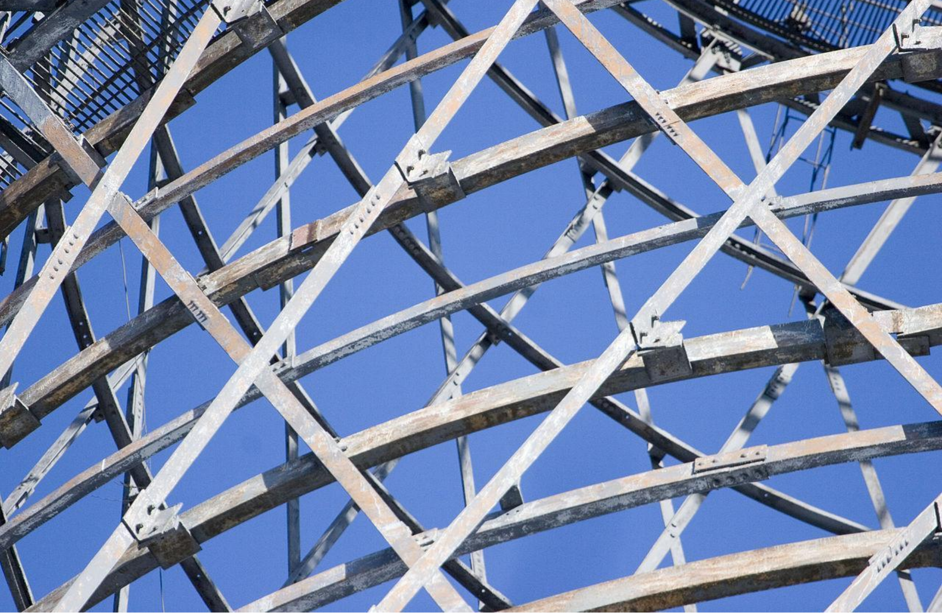
Шуховская башня (теле-радио башня на Шаболовке). 1922. Москва. Деталь конструкции
