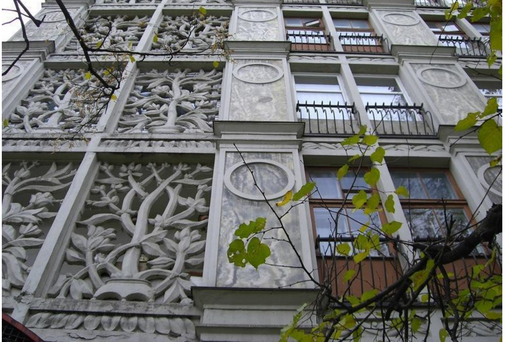
Жилой дом на Ленинградском шоссе. 1940. Москва. Архитекторы А. Буров, Б. Блохин. Инженеры А. Кучеров, Г. Карманов Фрагмент фасада
