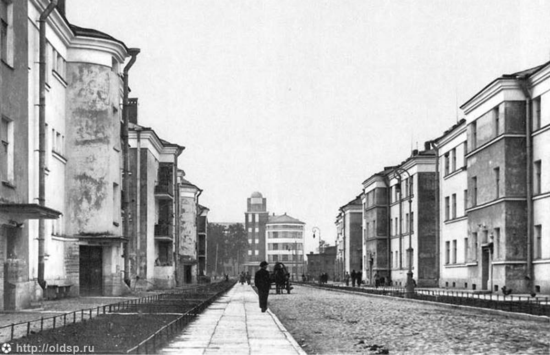
Жилой комплекс на тракторной улице. 1925-1927. (Ленинград / Петербург) Архитекторы А. И. Гегелло, А. С. Никольский, Г. А. Симонов и Н. Ф. Демков
