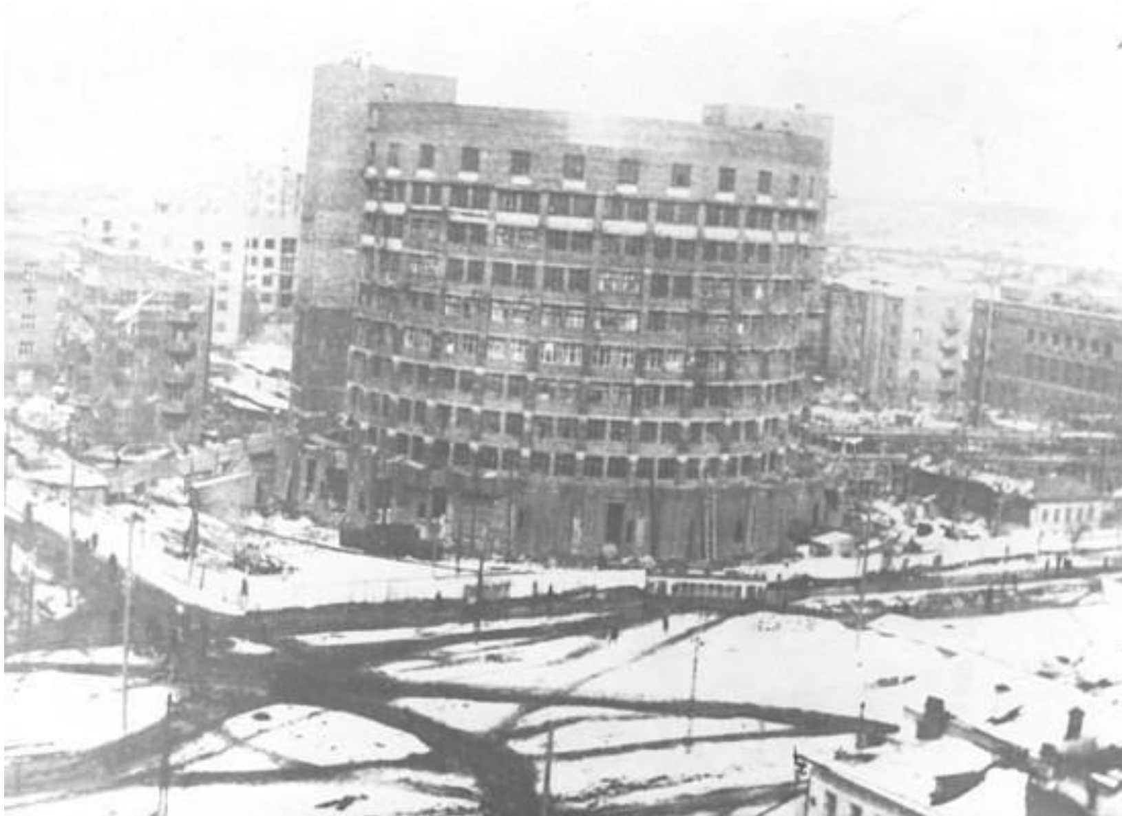
Городок чекистов. 1931. Свердловск. Архитекторы И. Антонов, В. Соколов, А. Тумбасов Строительство
