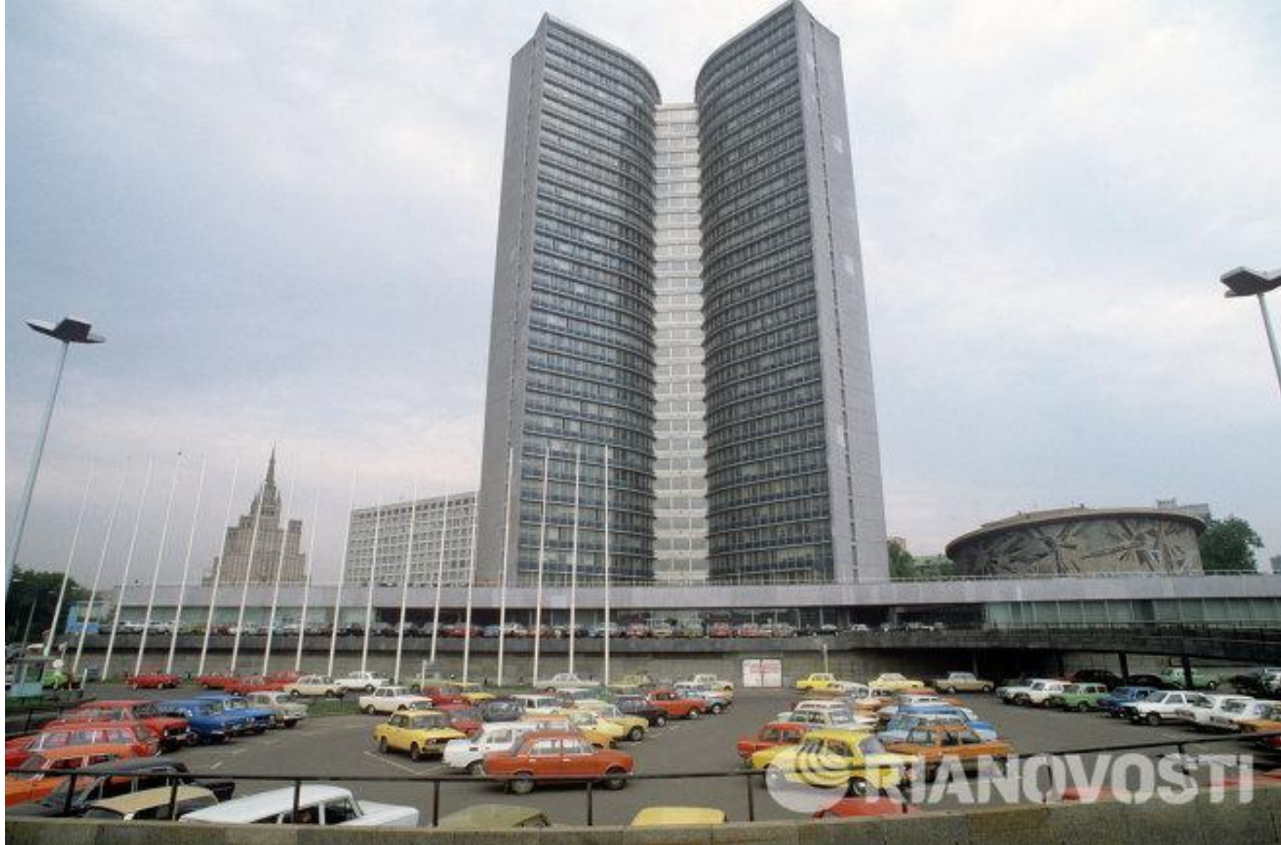
Здание СЭВ. 1963-1970. Москва. Архитекторы: М. В. Посохин, А. А. Мндоянц, В. А. Свирский. Инженеры В. И. Кузьмин, Ю. В. Рацкевич, С. Я. Школьников и др.
