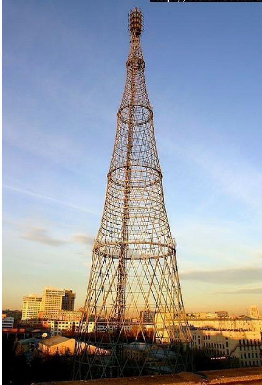
Шуховская башня (теле-радио башня на Шаболовке). 1922. Москва. Инженер В. Г. Шухов
