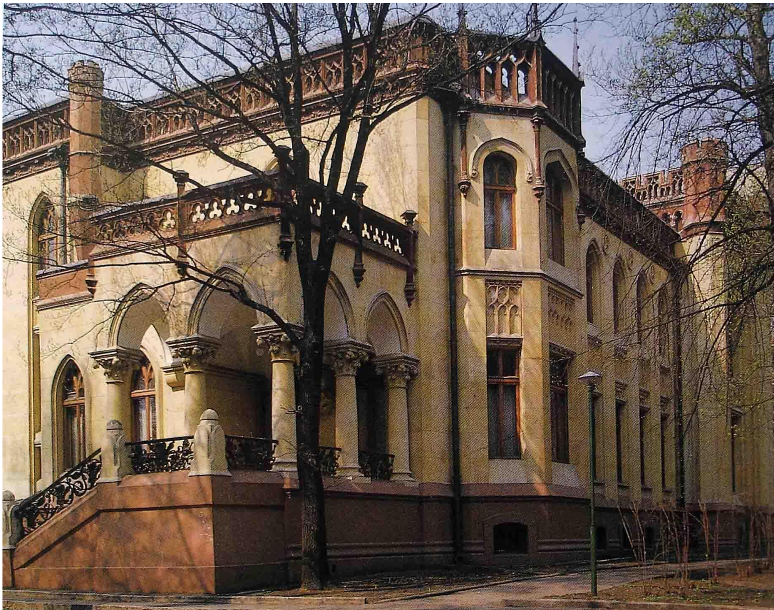
Ф. О. Шехтель. Особняк З. Г. Морозовой на Спиридоновке в Москве. Садовый фасад. 1893
