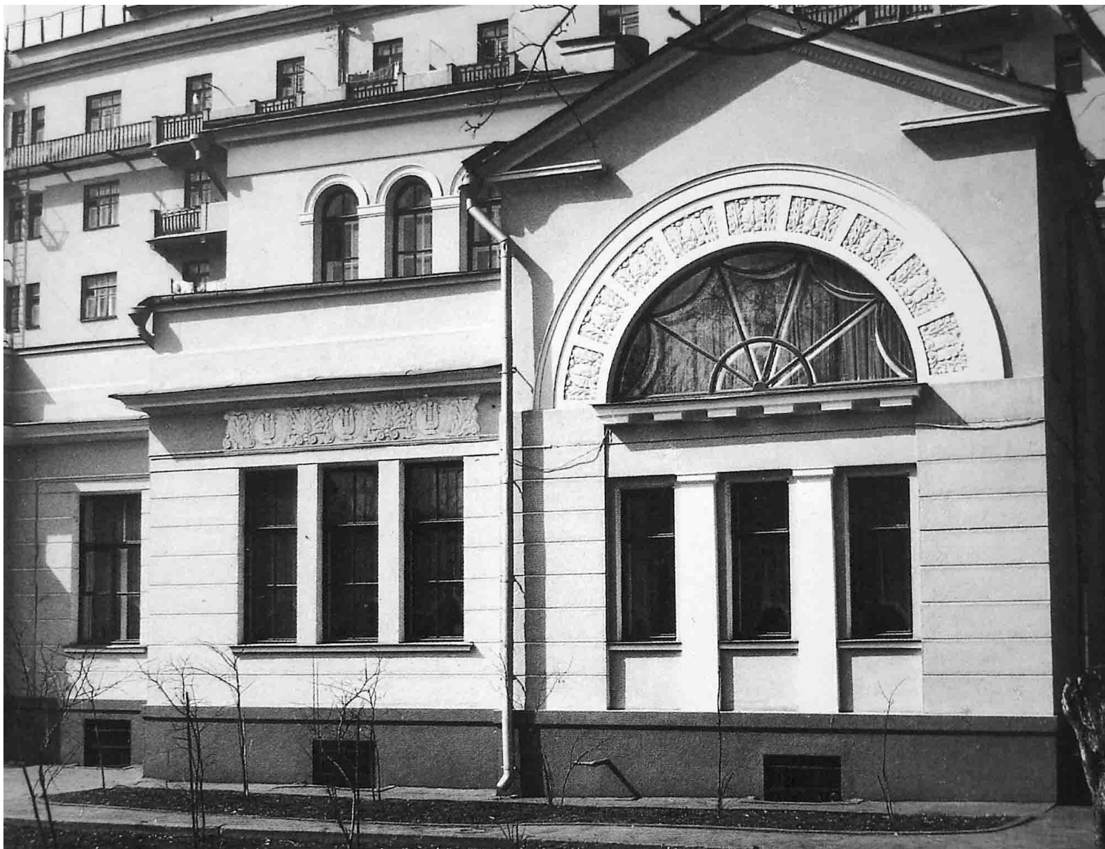
Ф. О. Шехтель. Особняк И. И. Миндовской в Георгиевском переулке в Москве. 1913-1915. Главный фасад
