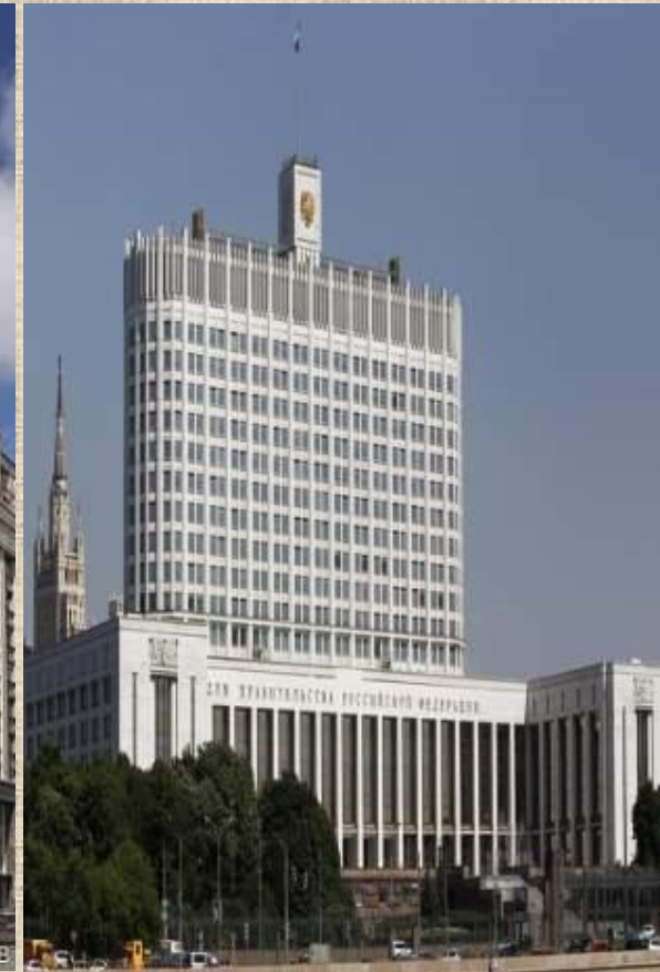
Здание Правительст ва
