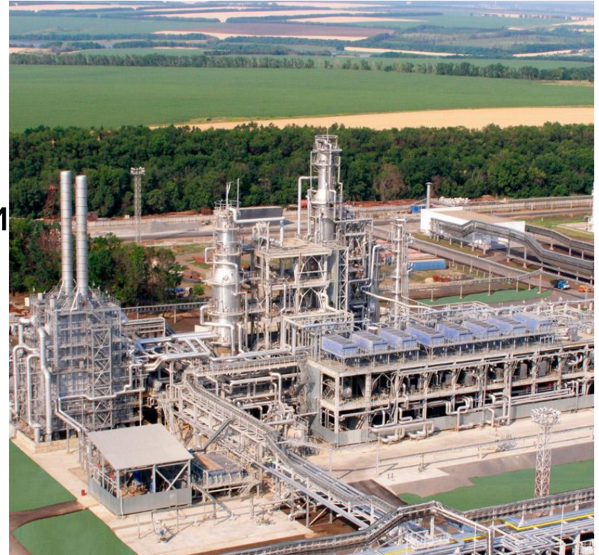
Общий вид установки первичной переработки нефти
