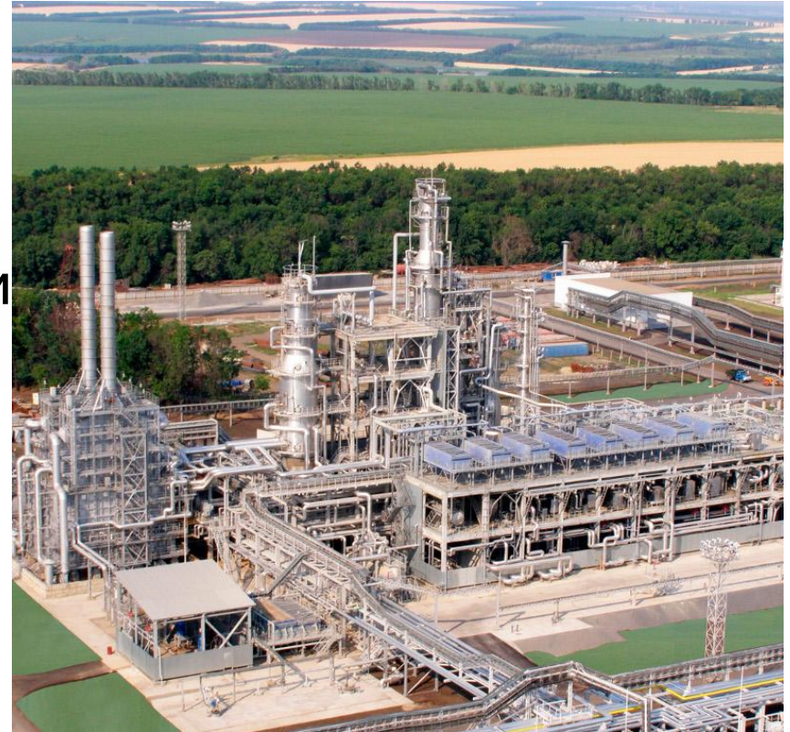
Общий вид установки первичной переработки нефти
