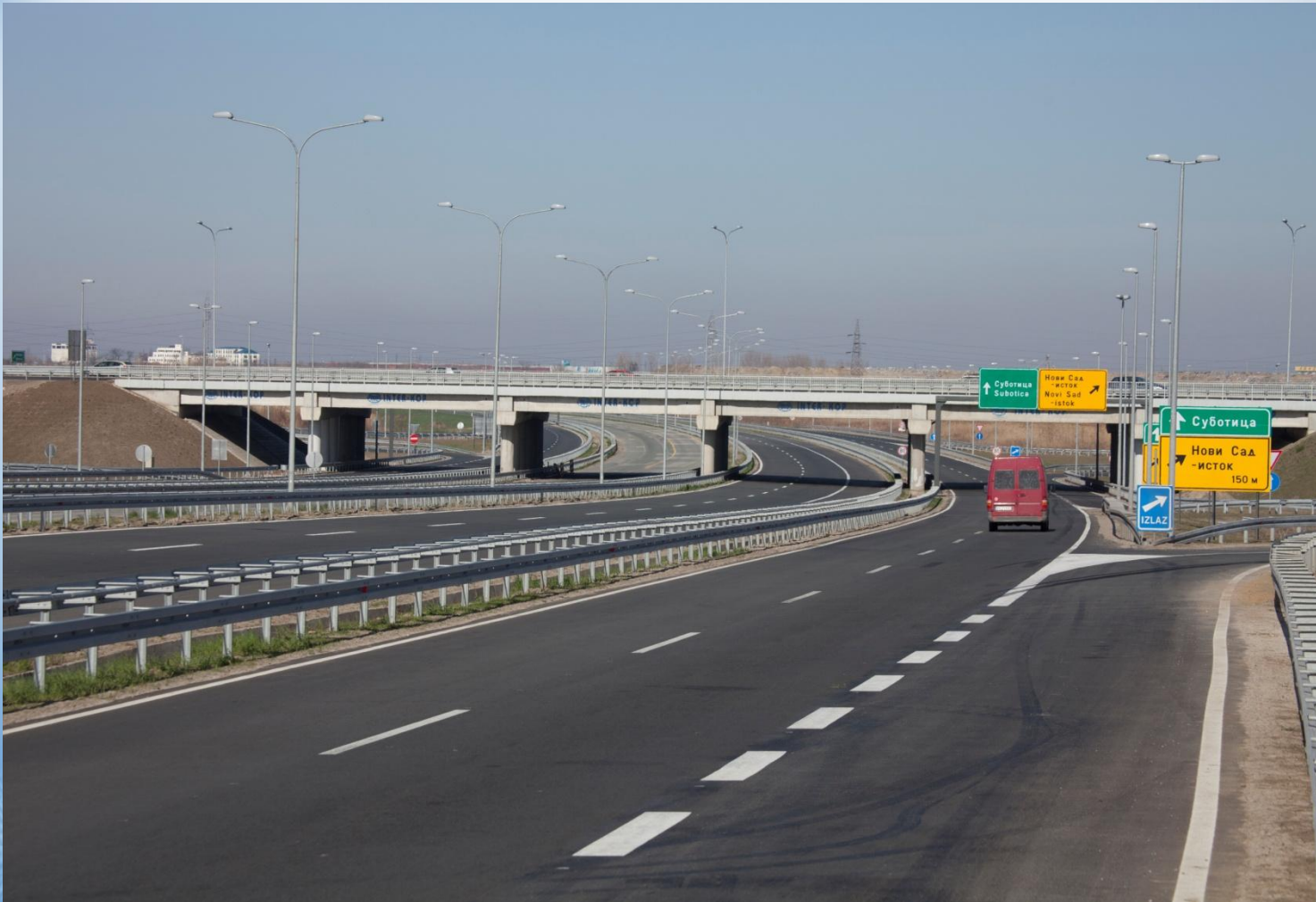
Строительство моста на Зренянинском узле
