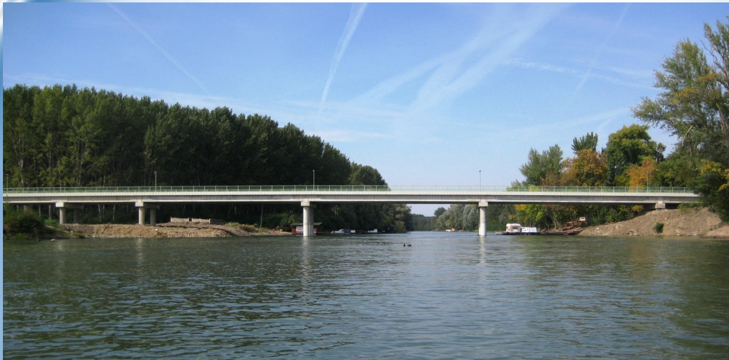
Мост через реку Тамиш в Сефкерине Мост через реку Тиса возле Ад
