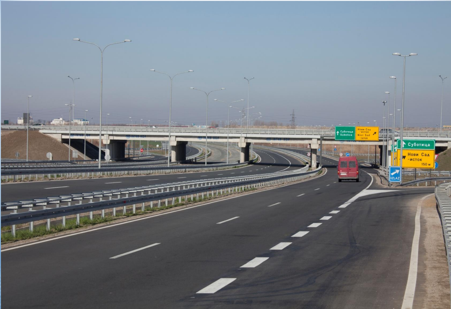
Строительство моста на Зренянинском узле
