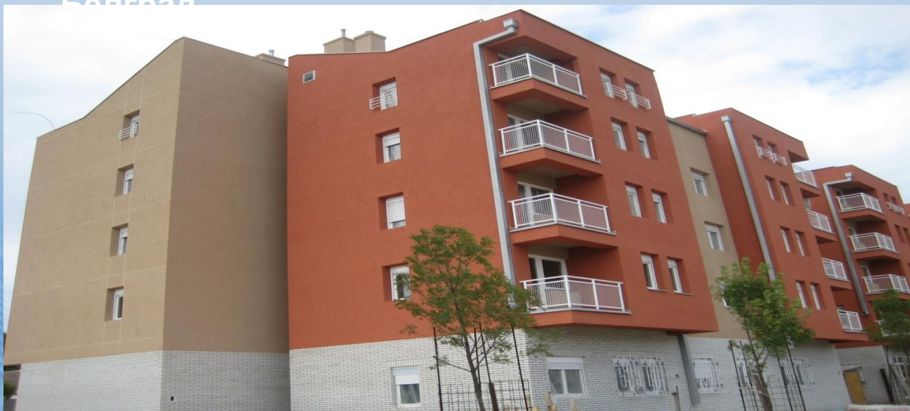
Жилищное здание в Войводжанской улице, Белград
