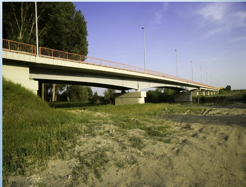
Мост через реку Тамиш в Сечня
