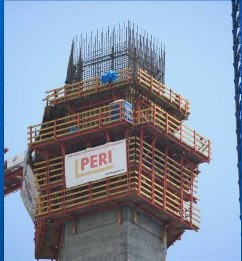
Австрийская опалубка PERI – очень технологична, позволяет обеспечить все типоразмеры и точную геометрию создаваемых конструкций. Эти качества необходимы для монтажа опор моста, сокращают сроки строительных работ.
