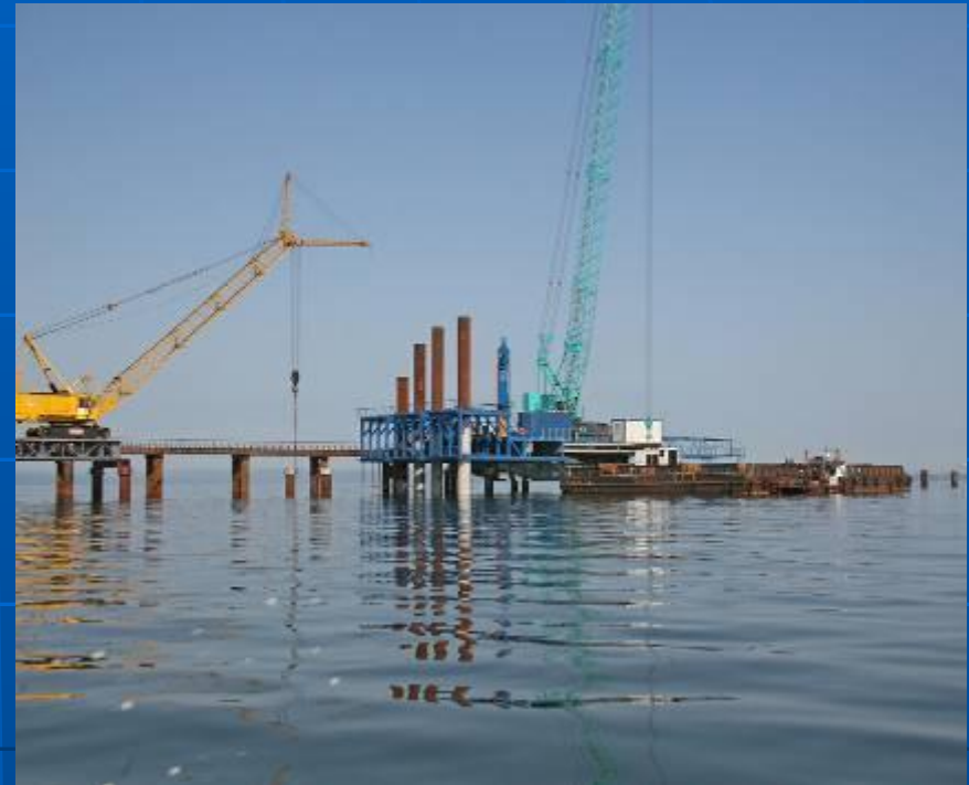
Комплекс по забивке свай
