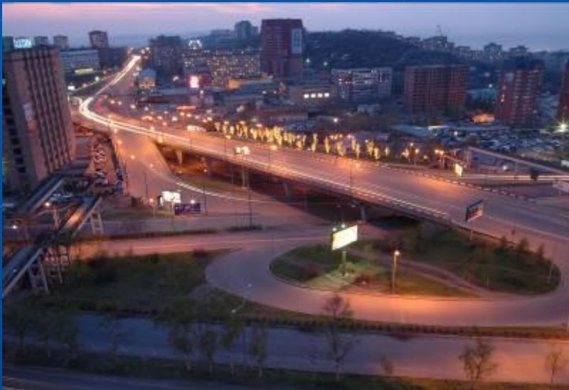
Развязка на ул.Гоголя, г. Владивосток
