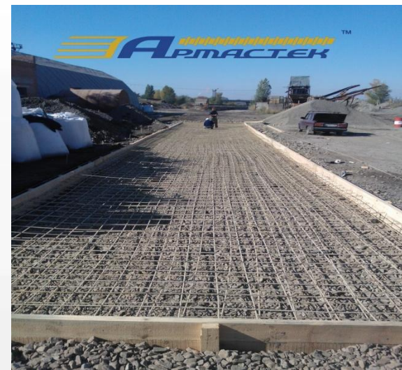
Заливка площадки под бетонные автовесы, г. Липецк
