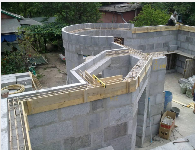
Строительство коттеджей, г. Краснодар
