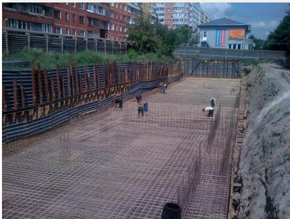
Тульская область. Строительство торгового центра. Заливка фундаментной плиты
