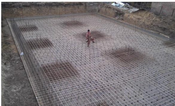
Заливка фундамента. Административное здание 3 этажа, г. Ростов-на-Дону, ул. Малиновского
