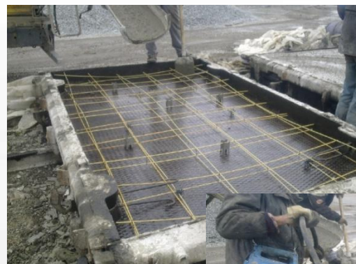
Изготовление дорожной плиты
