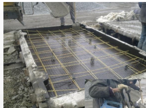
Изготовление дорожной плиты
