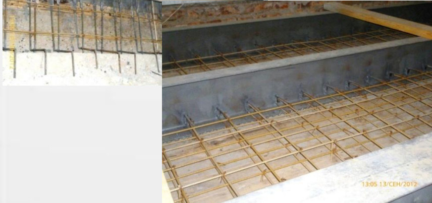
Ремонт плит перекрытия
