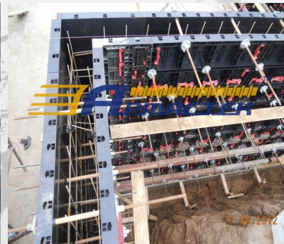
Строительство 2-х этажного коттеджа. Применение в несъемной опалубке, г. Ростов-на-Дону
