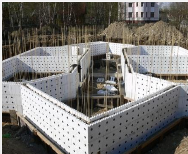
Строительство коттеджей, г. Петропавловск Камчатский
