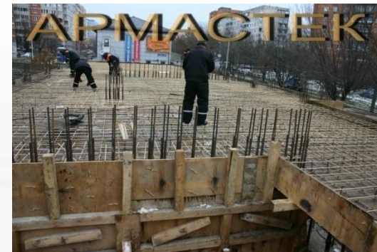
Тульская область. Строительство торгового центра. Плита перекрытия
