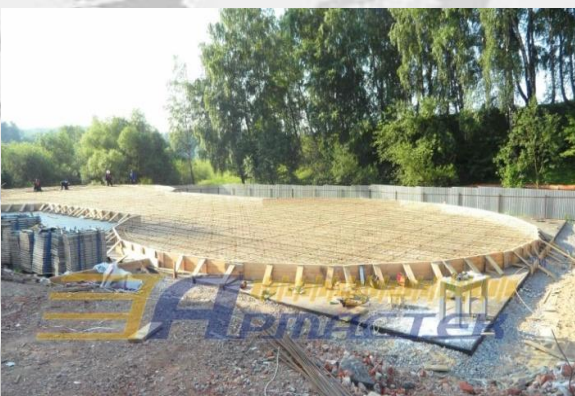
Заливка площадки под бетонные автовесы, г. Липецк
