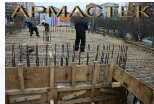
Тульская область. Строительство торгового центра. Плита перекрытия
