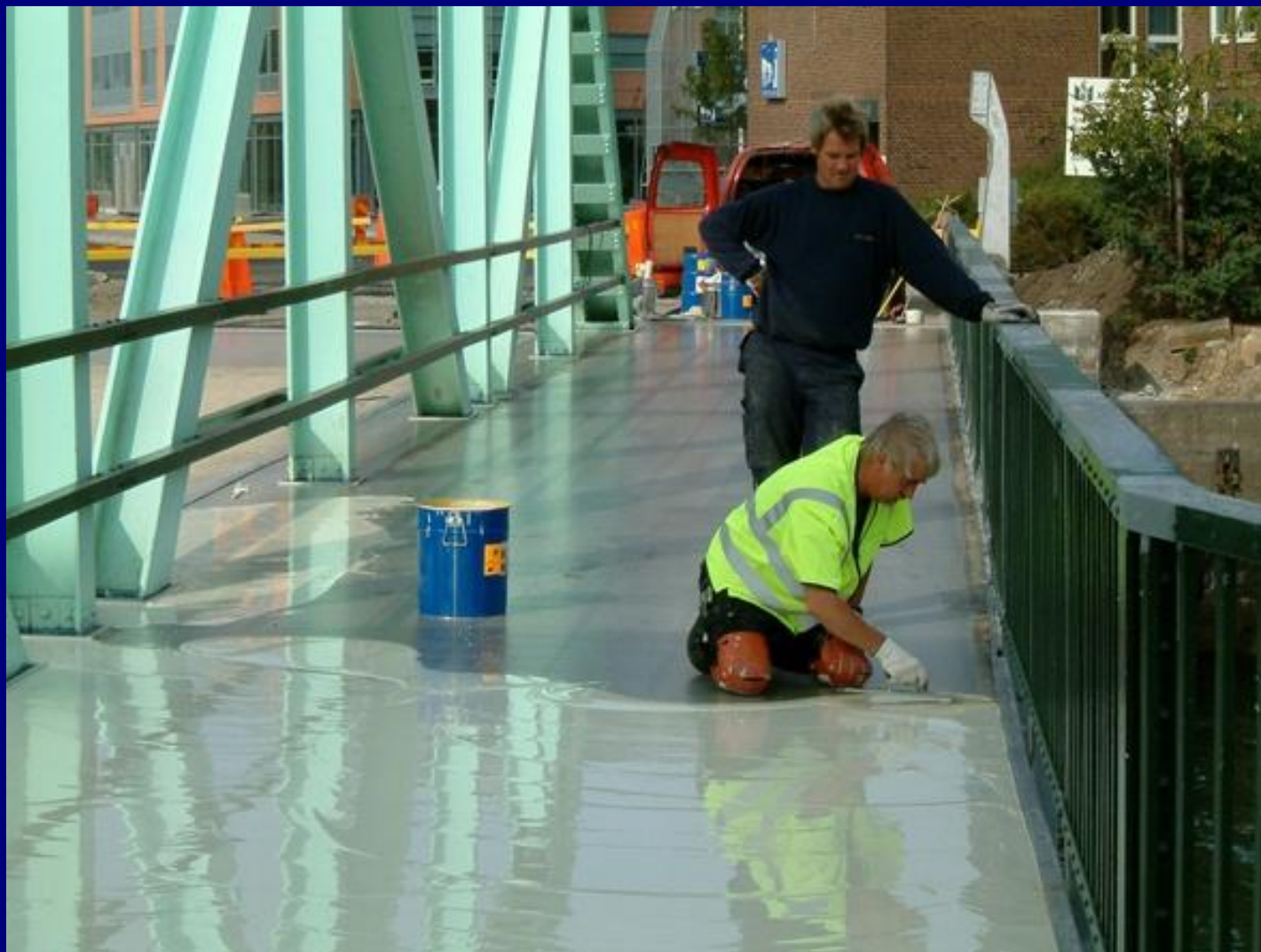
Нанесение гидроизоляционного слоя
