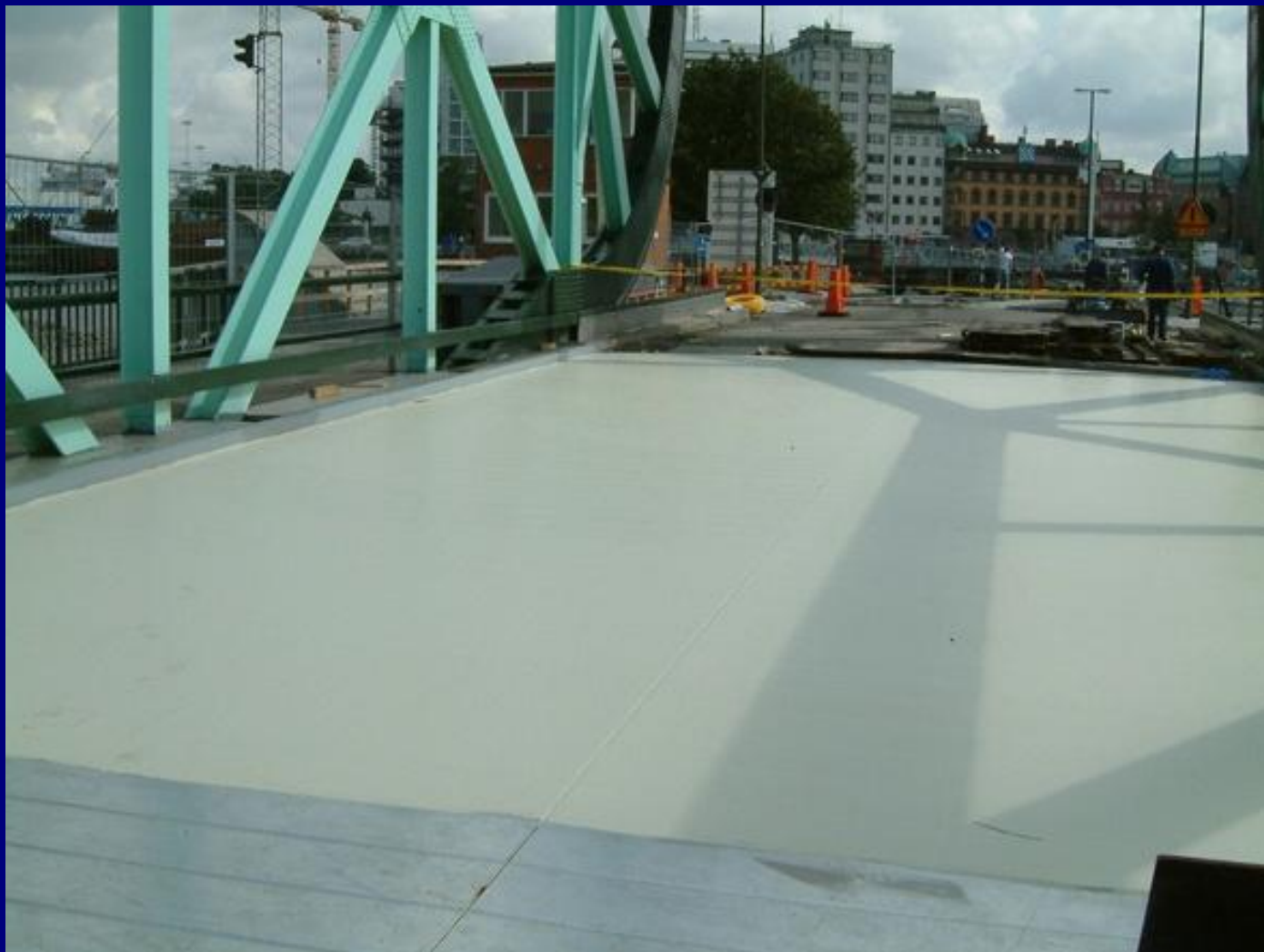
Нанесение гидроизоляционного слоя
