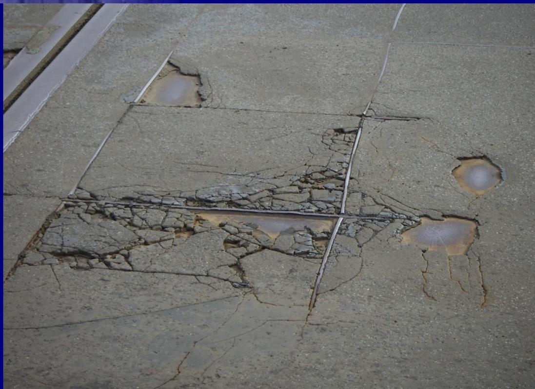
На разводных пролетах наносят полимерное покрытие на эпоксидной основе. Оно неэластично, поэтому через короткое время покрытие начинает разрушаться под воздействием динамических колебаний ортотропной плиты.
