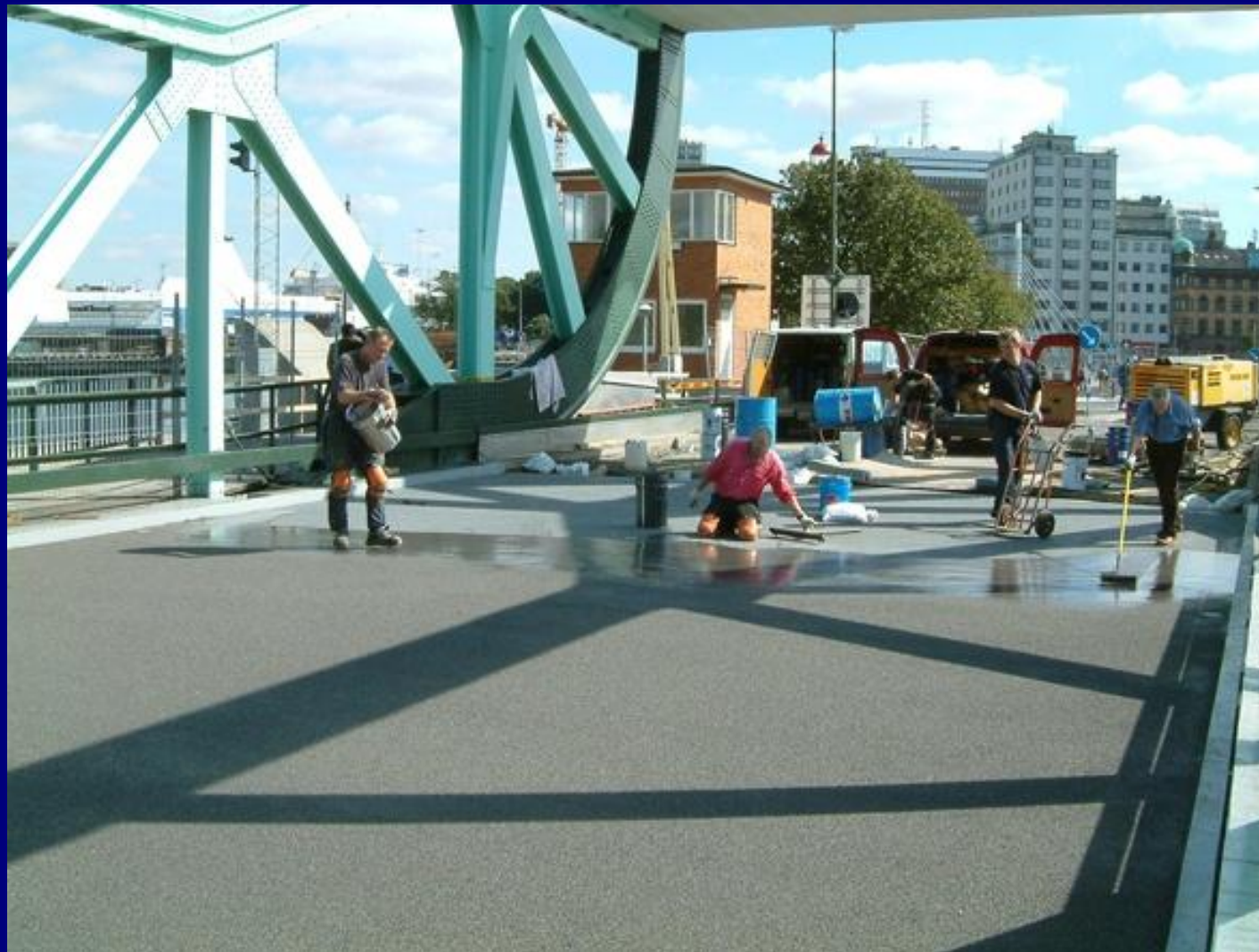
Набрасывание кварцевого песка на верхний слой мастики
