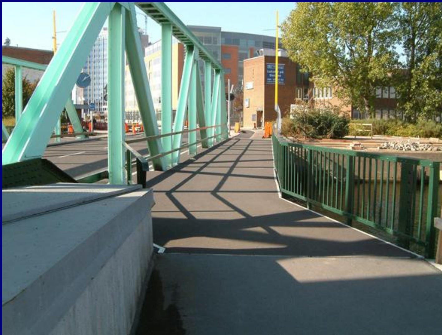
Готовое гидроизоляционное и износостойкое покрытие
