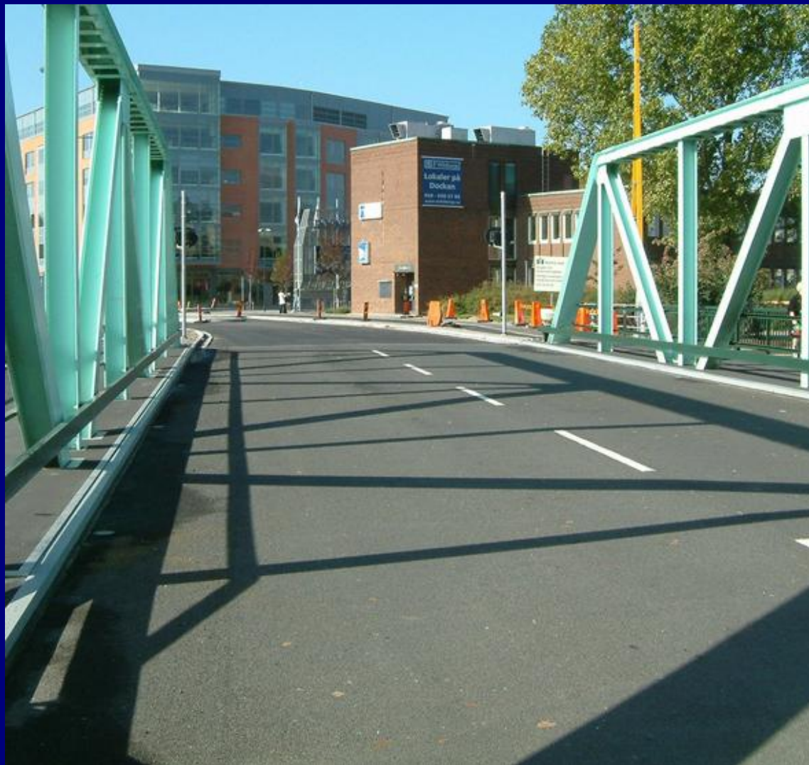
Готовое гидроизоляционное и износостойкое покрытие
