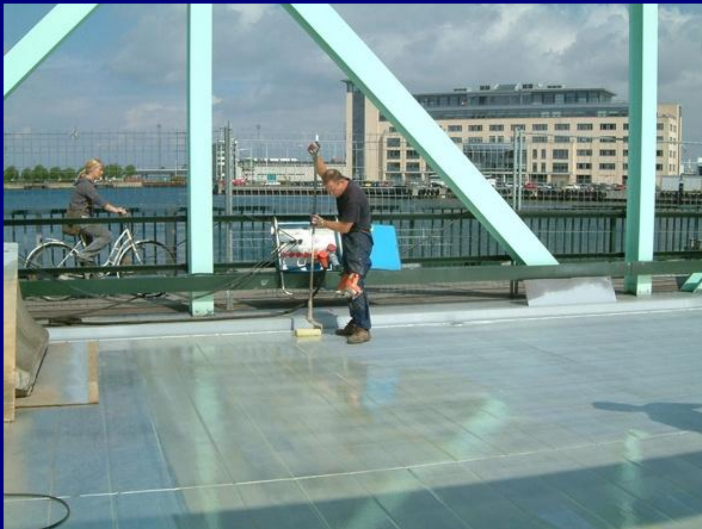
Нанесение грунтовки
