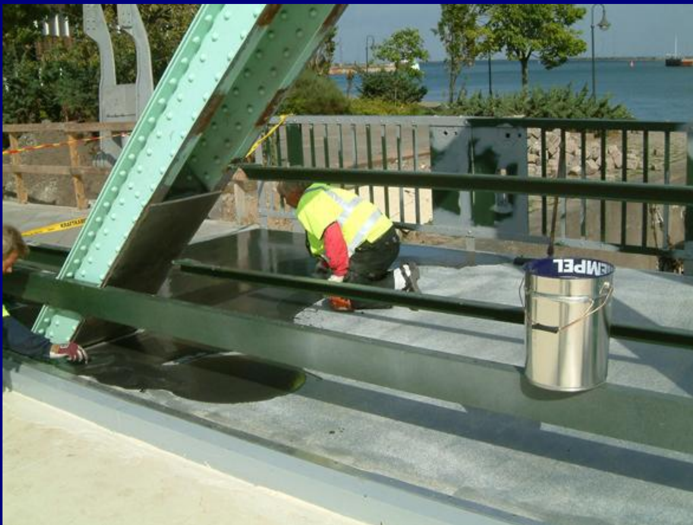
Нанесение износостойкого слоя
