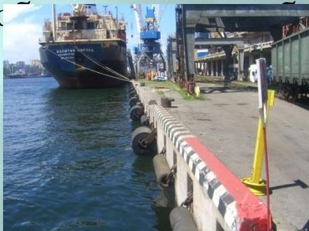
реконструируемая причальная линия рыбного терминала рассчитывается под вторую категорию нагрузки и прием судов с осадкой до 8 м. Реконструкция одного из причалов (150 м) предусмотрена на восприятие нагрузок нуле
