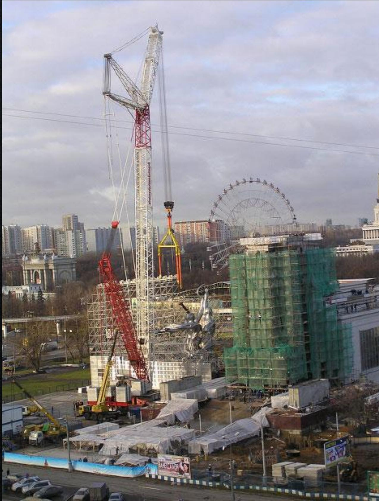
В разобранном виде кран грузился на 47 машин (одноразовая подача транспорта в порт.)
