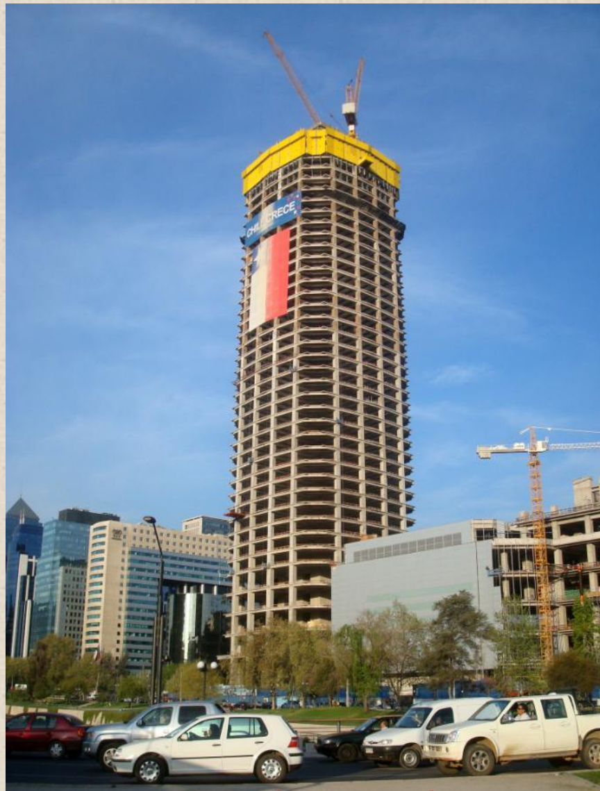
Строительство небоскрёба «Гран-Торре-Сантьяго» в столице Чили. Фото с сайта Panoramio.com
