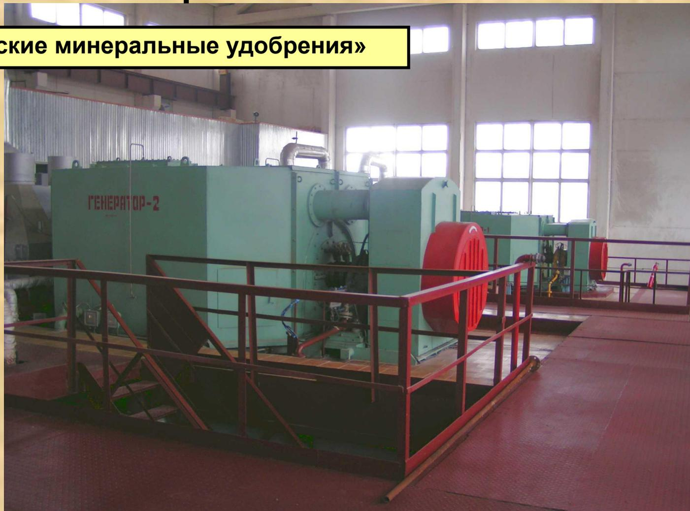
*В 2006-2009 годах реализован проект по утилизации ВЭР от сернокислотного производства с установкой паровых турбин 2x12 МВт. В 2010 году планируется запуск еще одной паровой турбины электрической мощностью 25 МВт.*
