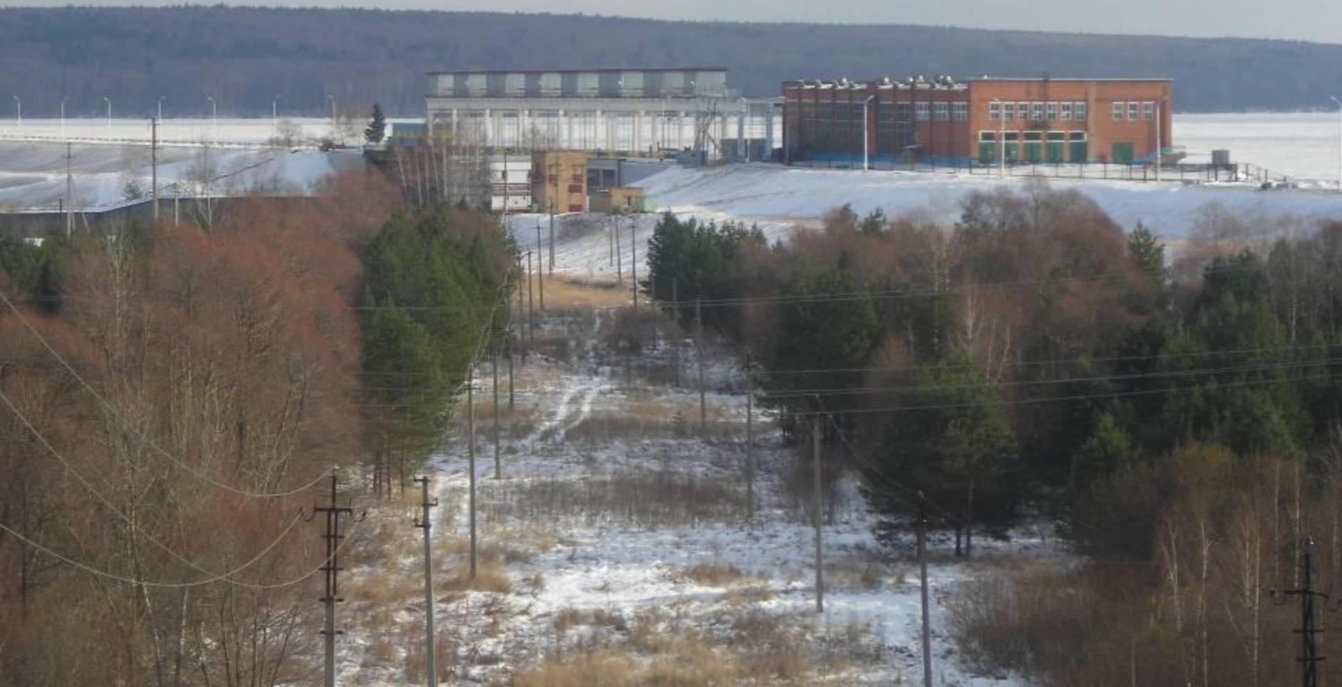
**При помощи глухого водослива уровень воды в верхнем бьефе удерживается в одном положении. При необходимости можно производить сброс воды через левобережные щитовые отверстия. Плотина рассчитана на пропуск до 3500 м<sup>3</sup> воды в секунду. Строительство плотины оказало большое влияние на естественный режим реки Суры. Подпор от нее распространился до 13 км выше по течению, давая возможность использовать полученные запасы воды на промышленные нужды, водоснабжение, орошение.**
