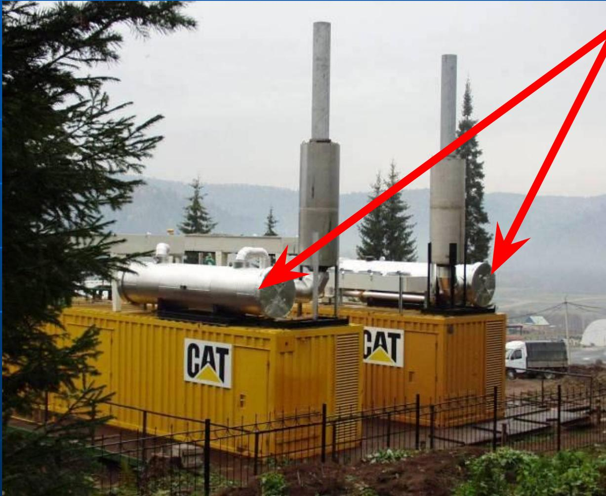
Система глубокой утилизации тепловой энергии 2,16МВт у каждого агрегата (котлы утилизаторы).
