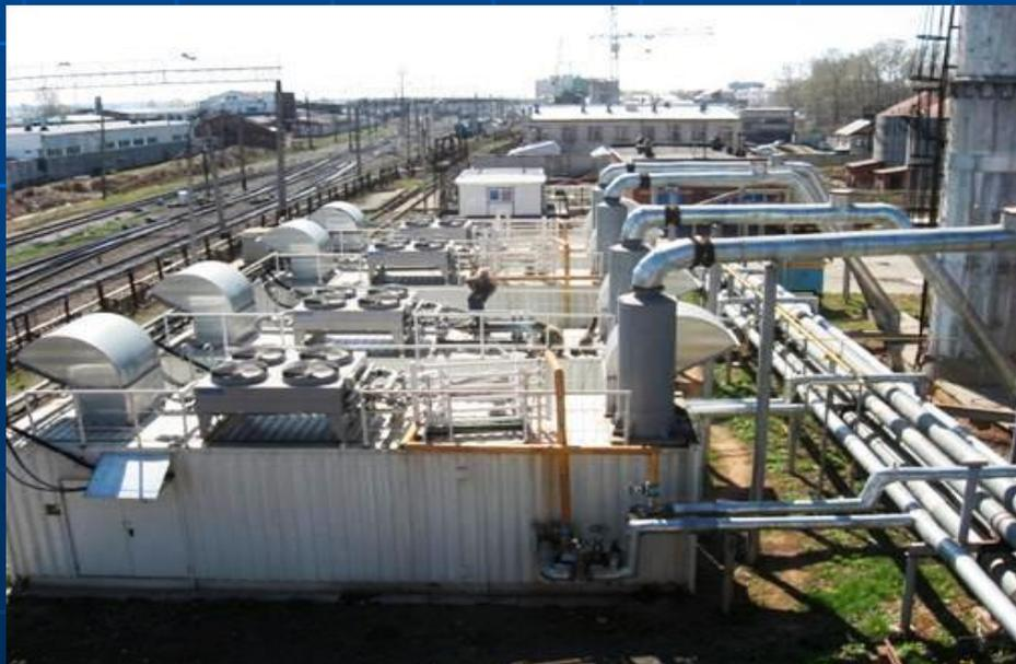
В соответствии с действующим в РФ ГОСТом Р 51249-99 норматив удельных средневзвешенных выбросов оксидов азота  $\text{NO}_x$  для промышленных дизелей должен составлять 9-10 г/кВтч. Предлагаемые к размещению в городской черте ГПА имеют удельный выброс  $\text{NO}_x$  1,21 г/кВтч, что в 7,44 раза ниже действующих в России экологических требований.
