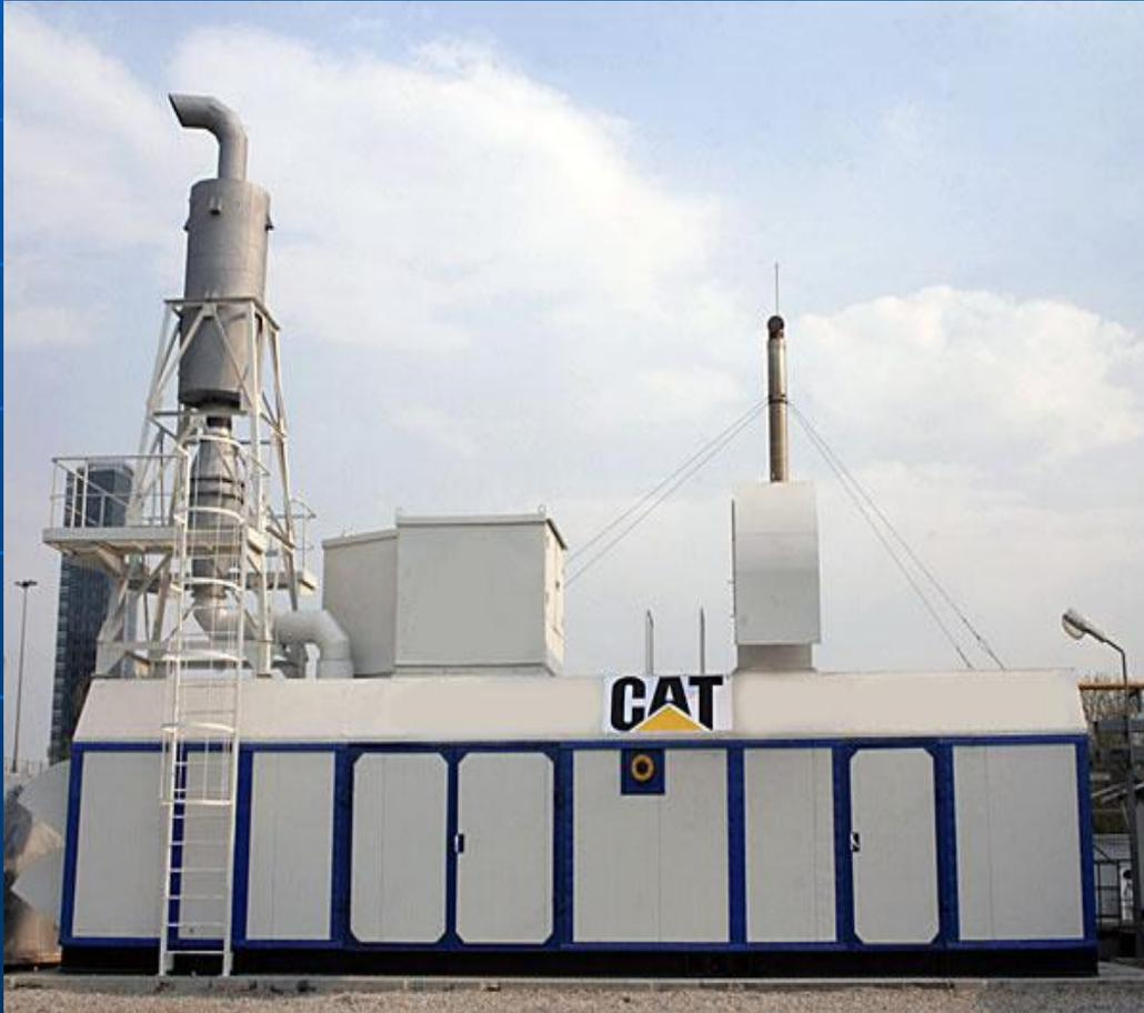
В качестве основного оборудования под установку на мини-ТЭЦ приняты газопоршневые агрегаты (ГПА) производства «Caterpillar, Inc.» США, выполненные на базе газопоршневых двигателей G3520C с установленной мощностью по электроэнергии 2МВт, оснащенные системой глубокой утилизации тепловой энергии 2,16МВт.
