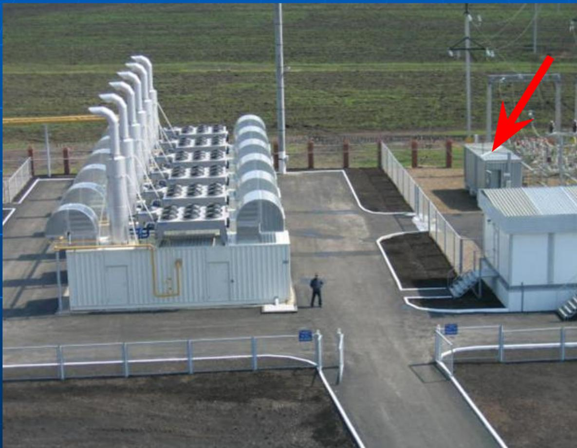
Распределительная подстанция на 10,5 кВ или 6,3кВ, в зависимости от напряжения в действующих электрических сетях энергорайона. Частота 50Гц.
