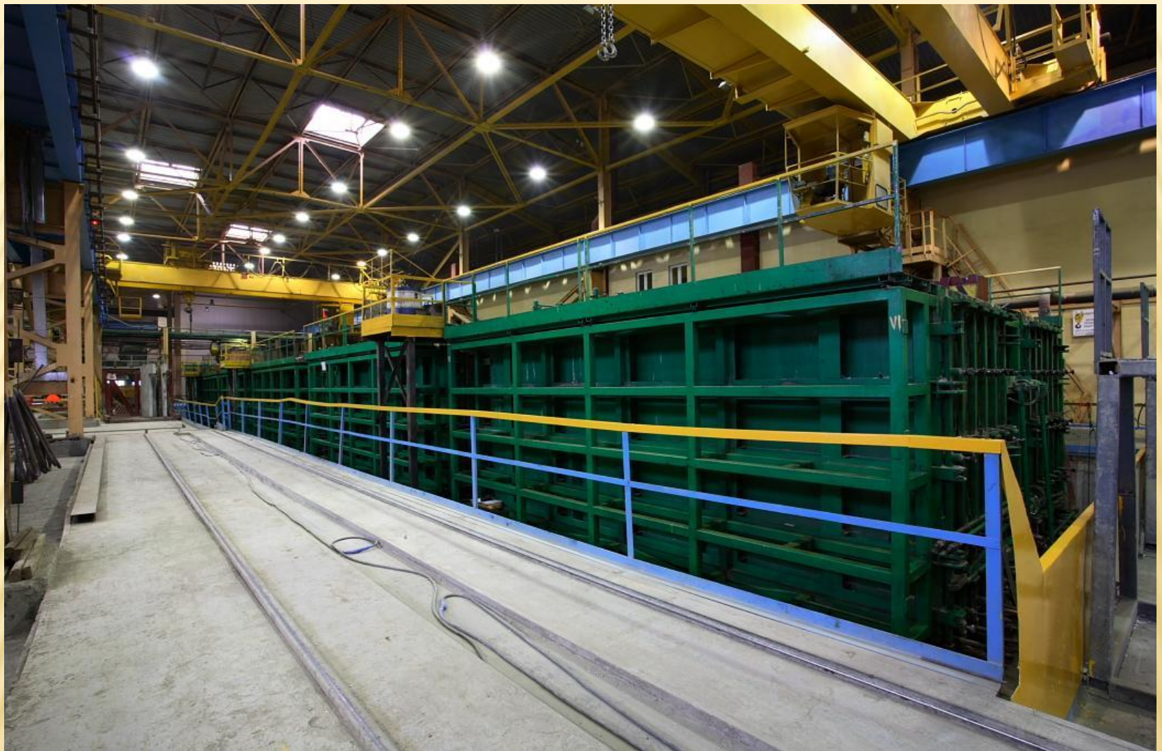
Мобильный ДСК «Стройконструкция-5», ЗАО «Мосстроймеханизация-5», г. Москва
