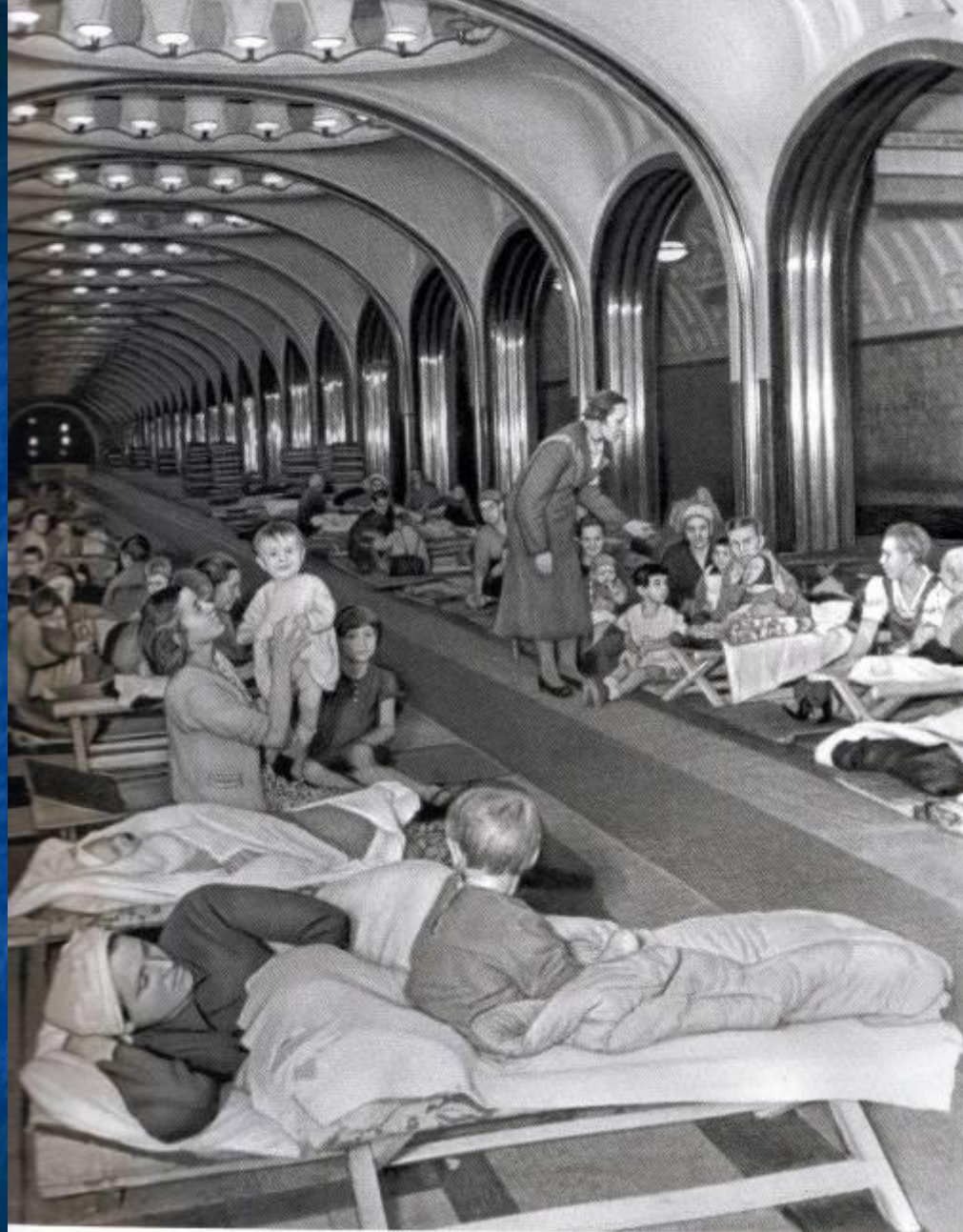
Станция метро «Маяковская» во время воздушной тревоги
