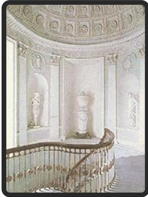
Исполняя пожелания заказчицы, архитектор сделал один спиралевидный марш, имеющий 41 ступень из серого мелкозернистого гранита, вписывающийся в овал помещения и не имеющий обычных подпорных стенок. Принцип устройства марша состоял в том, что концы ступеней (длиной до 40 см) были вставлены в специальный канал, выбранный в стене, и заклинены камнем. Кроме того, все ступени своими кромками соединялись посредством закруглений и выемок и опирались друг на друга.
