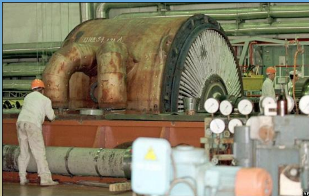
Демонтаж турбины Чернобыльской АЭС
