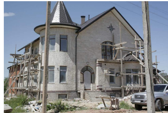
строительные и монтажные работы на объекте
