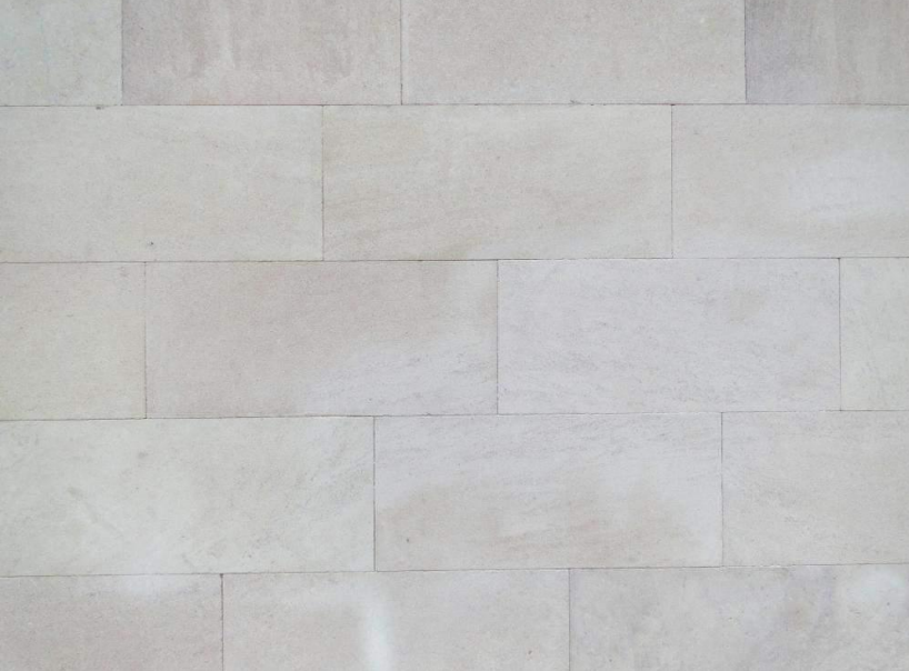
Плитка. Стандартные размеры: 35 x 16 x d, 35 x 25 x d. Фаски А, В и С.
