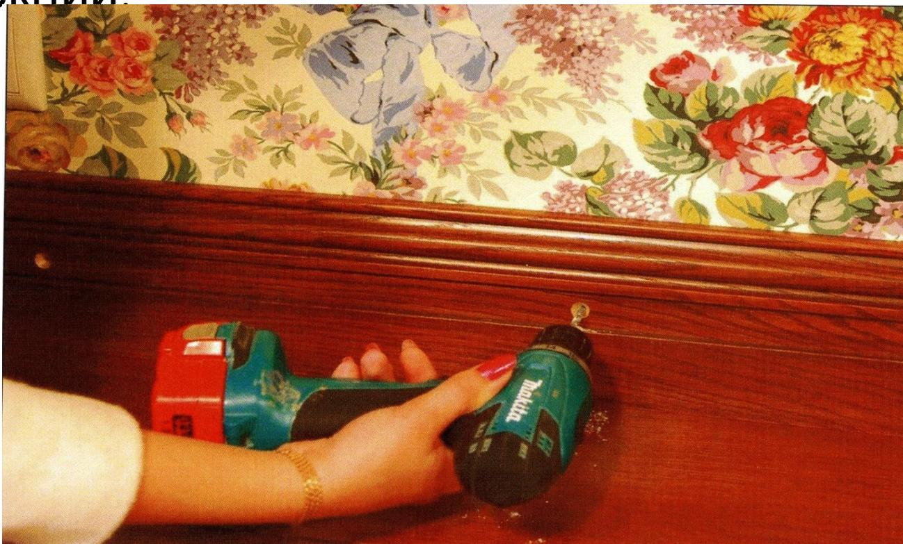
В частности, наличие отверстий с зенковкой в пазах профилей позволит быстро и точно выполнить разметку и крепление базовых профилей.
