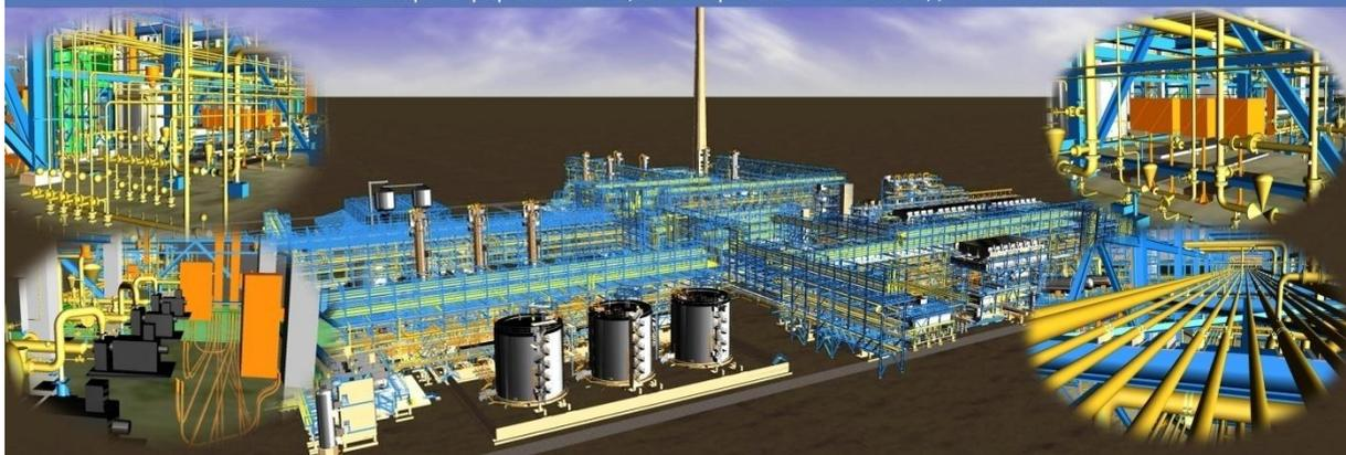
**Комбинированная установка производства серы для нового комплекса нефтеперерабатывающих и нефтехимических заводов, рассчитанного на ежегодную переработку до 14 млн. тонн высокосернистой нефти.**
