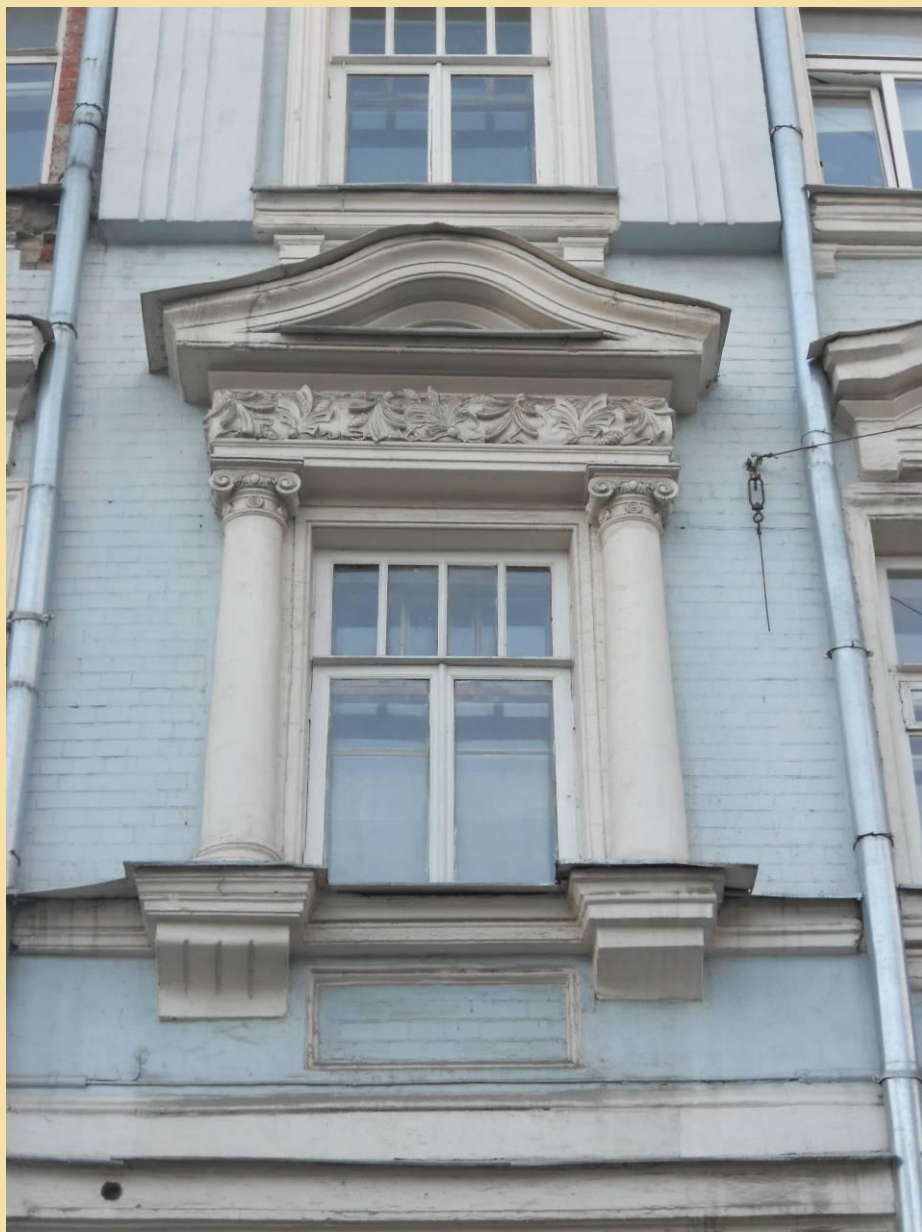
Москва. Дом 19 века. Балку над окном держат две колонны.
