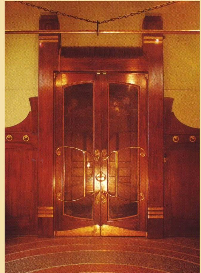
Дверная коробка хорошо видна в дверях, которые внутри здания. Но и наружных дверях она тоже есть. Ее легко увидеть, если посмотреть к чему крепятся петли, на которых поворачивается дверь.
