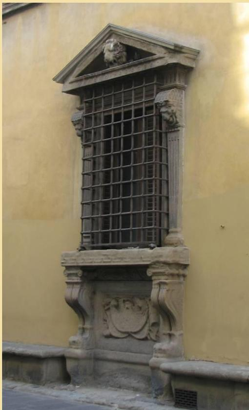
Здесь подоконник перешел в карниз идущий по периметру всего здания
