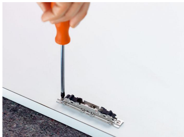
Установка на фасаде симметричного крепления фасада
