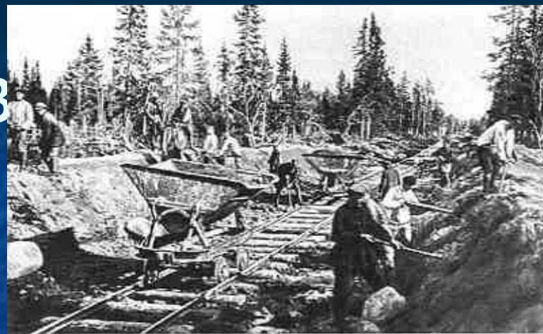
Соловецкая железная дорога. Строительство пути. 1928 г.
