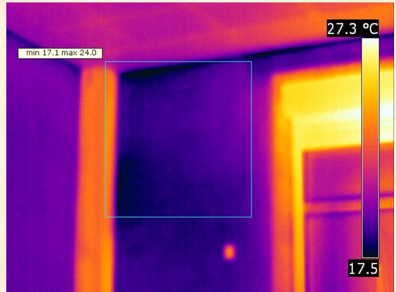
Термограмма 22, торговый зал. Переохлаждение внутреннего угла до 17°C (выделено прямоугольником), вызванное низкими теплоизоляционными свойствами стен.
