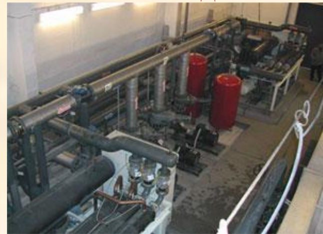
На фото: тепловые насосы и теплосъемный коллектор.
