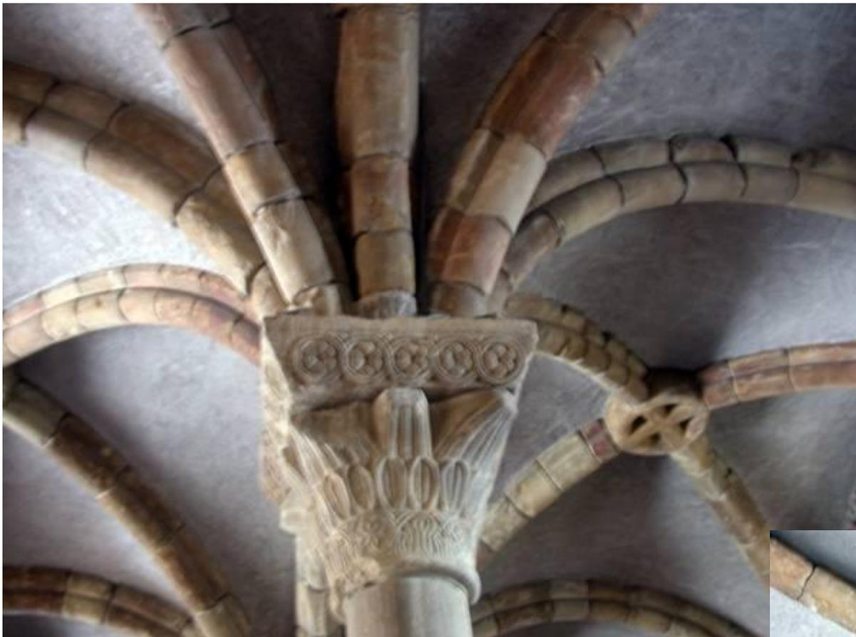
**НЕРВЮРА** – арка, образующая укрепляющее свод ребро. Нервюры образуют каркас, несущий основную нагрузку тяжёлого свода.
