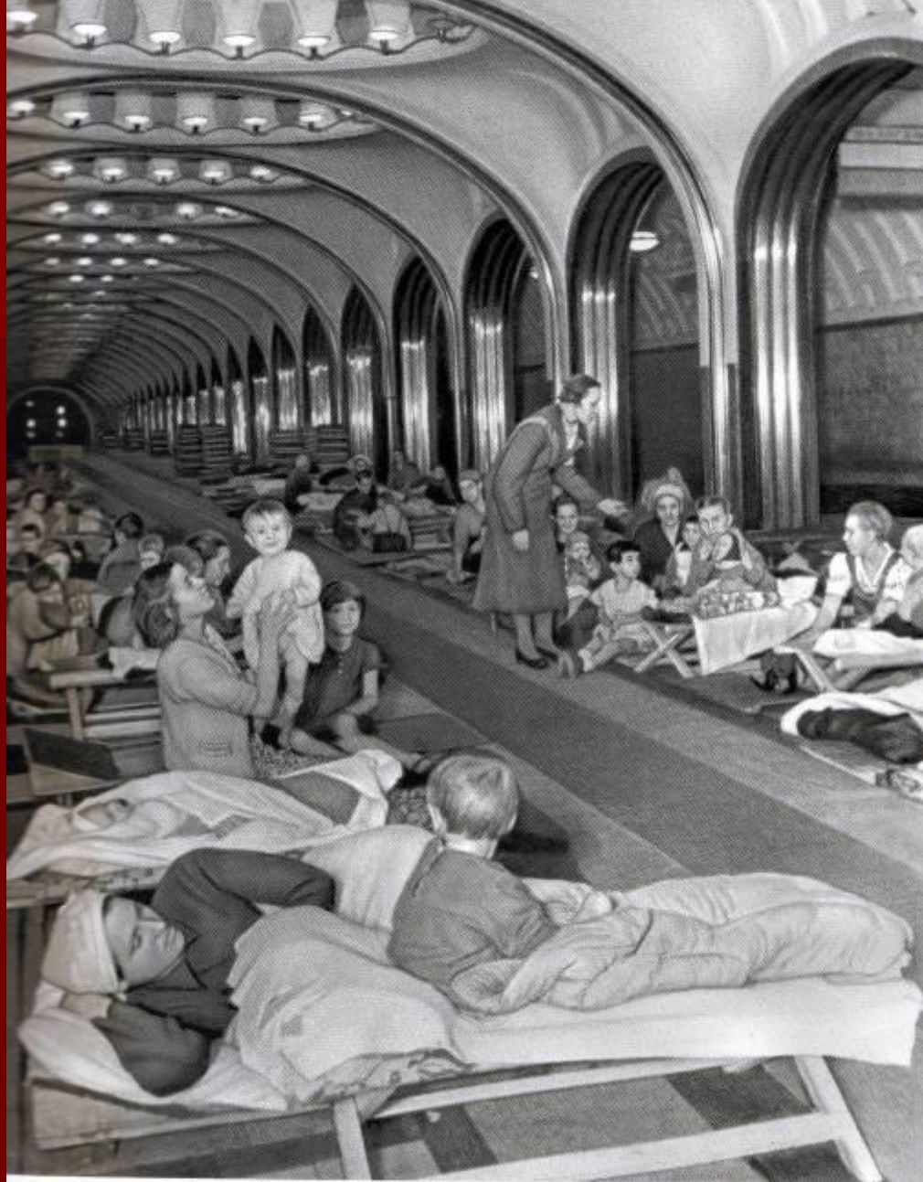
Станция метро «Маяковская» во время воздушной тревоги
