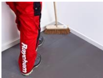
1. Удалите мусор с покрытия
