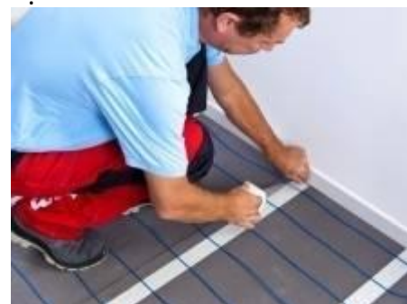
7. Закрепите поверх кабеля сверху сетчатой лентой.
