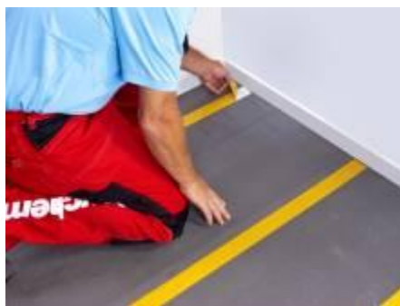
5. Снимите верхний защитный слой.
