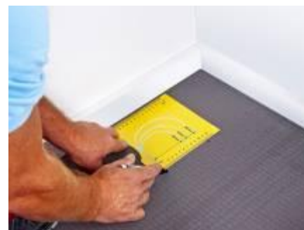
3. Определите треб. Шаг укладки
