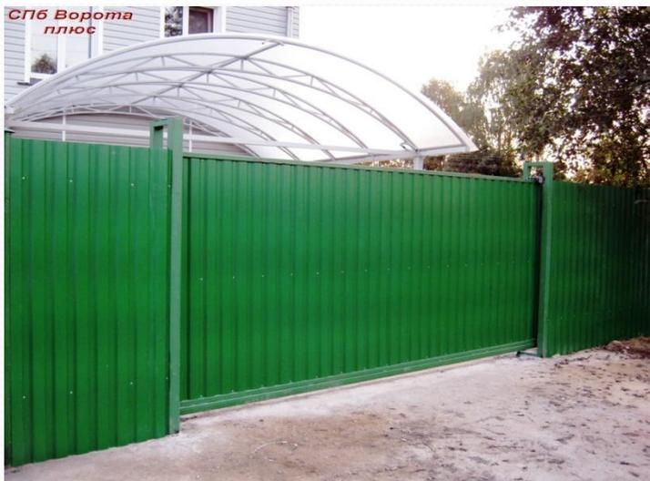
Ворота откатные - труба профильная 60\*40\*2, труба профильная 20\*20\*2, направляющая балка ЭКО, опора ЭКО, ролик концевой, заглушка, столбы, ловитель нижний, ловитель верхний, швеллер 18\*626\*3, арматура, цемент+песок
