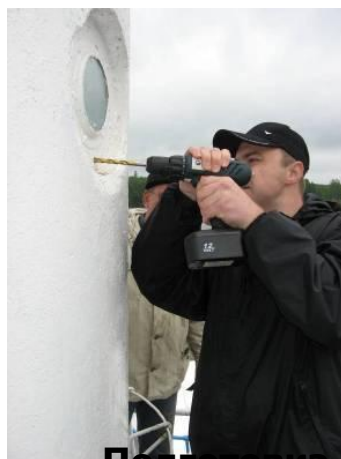
Подготовка отверстия для антенного кабеля
