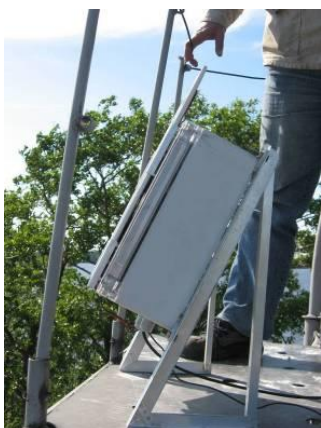
Шкаф с GSM-шлюзом и солнечным модулем
