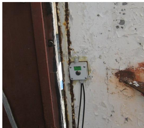
Извещатель датчика открытия 1-ой двери
