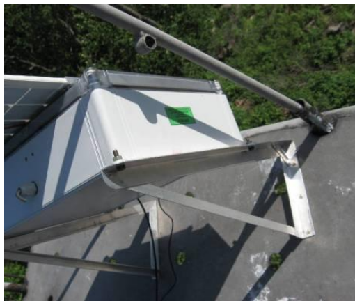
Шкаф с GSM-шлюзом и солнечным модулем
