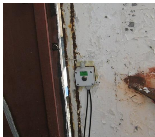
Извещатель датчика открытия 1-ой двери
