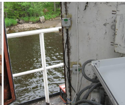
Извещатель датчика открытия 2-ой двери и самописец напряжения РИТЭГ
