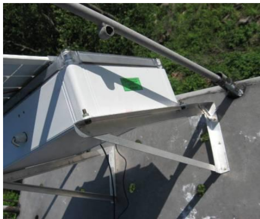
Шкаф с GSM-шлюзом и солнечным модулем
