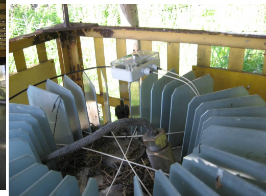
Обмотка РИТЭГа оптоволоконном
