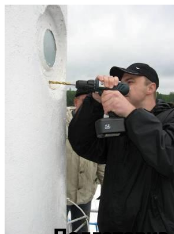
Подготовка отверстия для антенного кабеля
