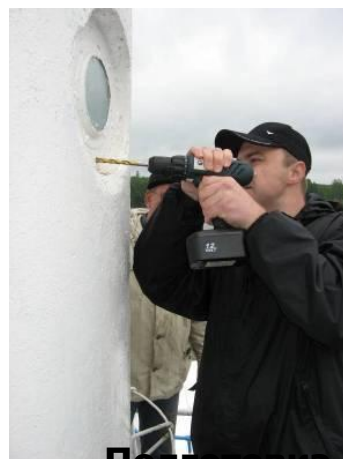
Подготовка отверстия для антенного кабеля
