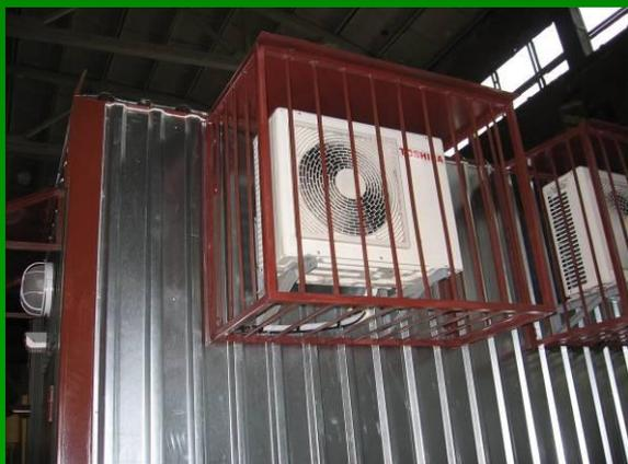
Система климат-контроля имеет в своем составе кондиционеры, выступающие за корпус блок-контейнера, наружные части которых защищены противовандальной решеткой, а сверху для защиты от осадков – снеговодозащитным козырьком, выполненном в виде многогранного объема со скошенной верхней плоскостью.
