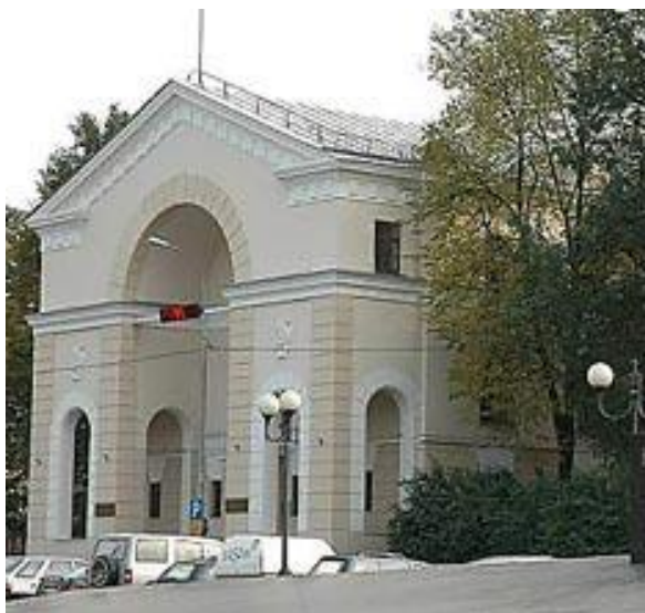
Федеральный Центр Обработки Данных, г.Москва
