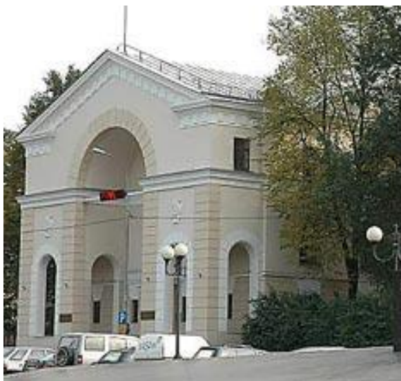
Федеральный Центр Обработки Данных, г.Москва
