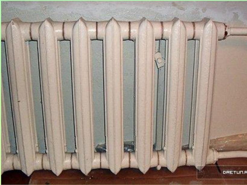
**Старый радиатор, не имеющий вентиля контроля температуры отопительной системы в квартире.**
