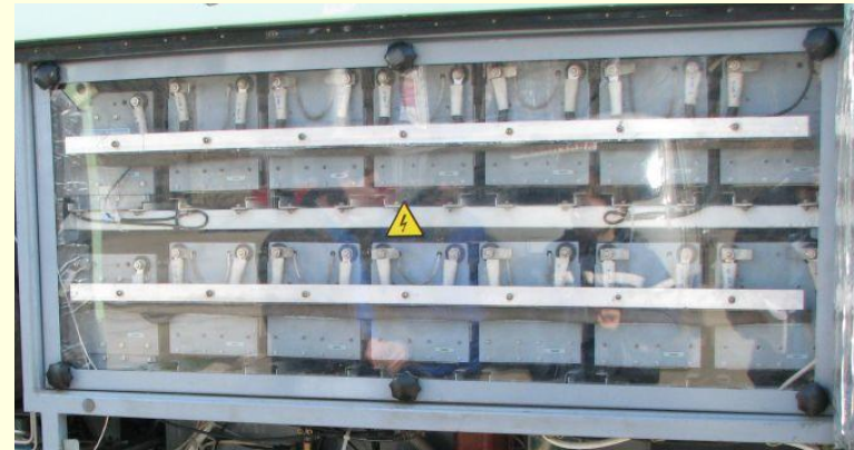
Воздушное централизованное охлаждение
