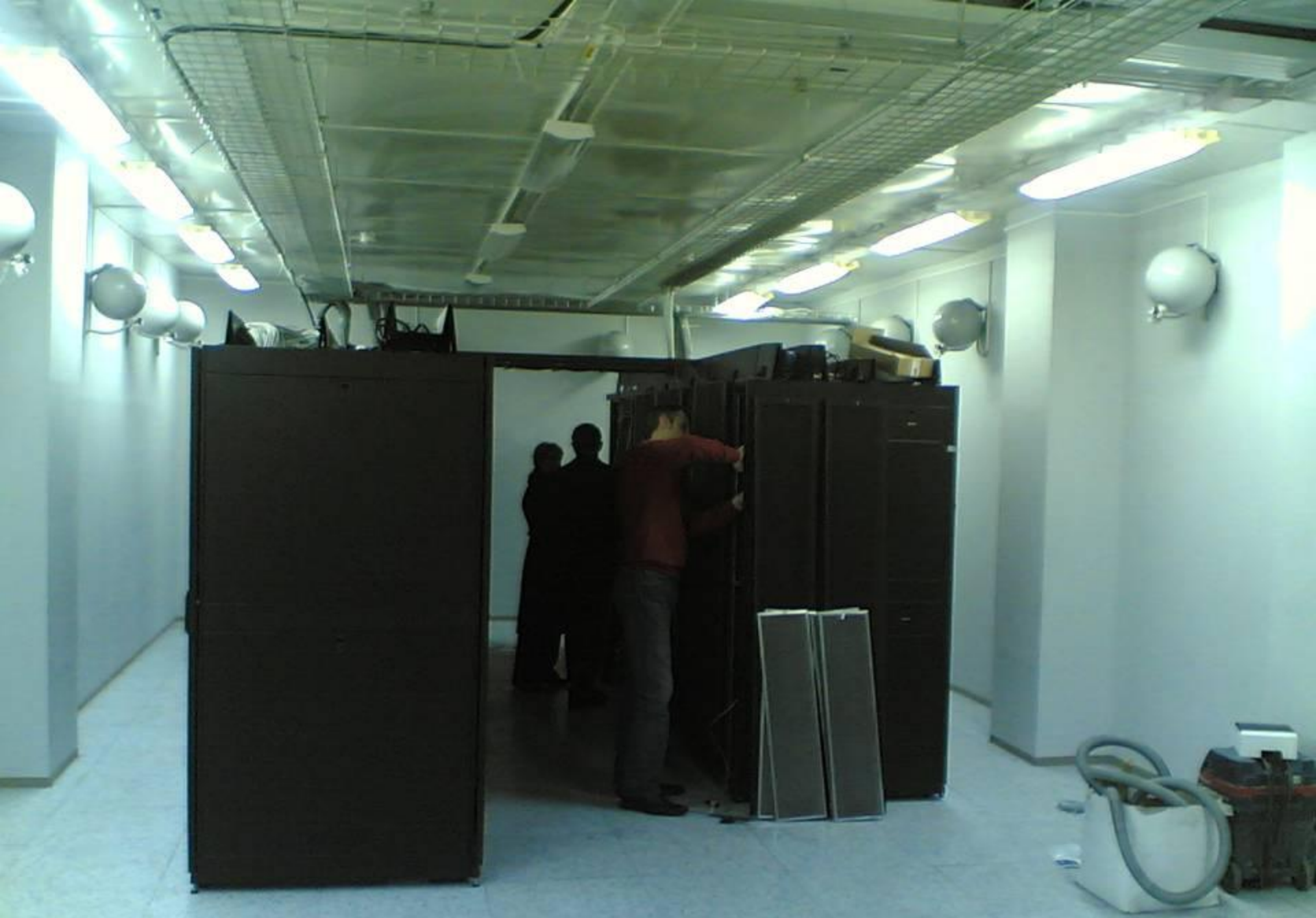
Монтаж оборудования ЦОД
