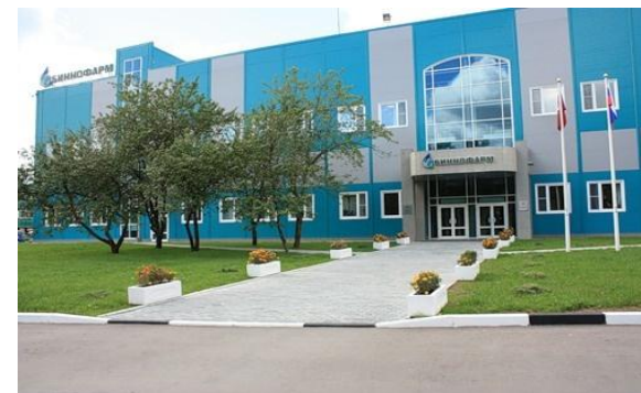
Главный вход в производственный комплекс «Биннофарм»
