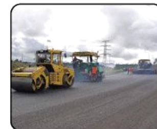
Безупречное дорожное покрытие!
