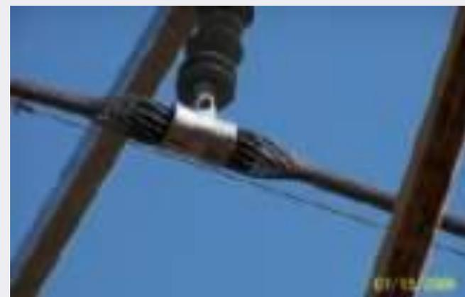
Традиционную проблему для алюминия представляют сплющивание провода под натяжной арматурой – избавиться от них позволяет процедура обратной опрессовки проводов АССС.
