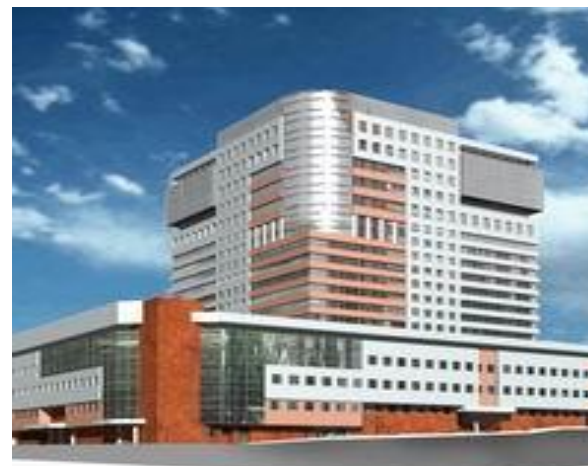
Торговый центр «ЧЕРЕМУШКИ»
