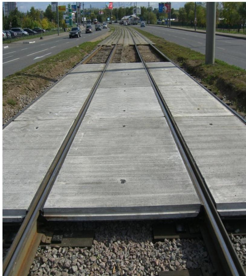
**Блочная конструкция для трамвайных путей и сборное железобетонное покрытие обладают эстетикой внешнего вида, долговечны и уменьшают затраты при эксплуатации.**
