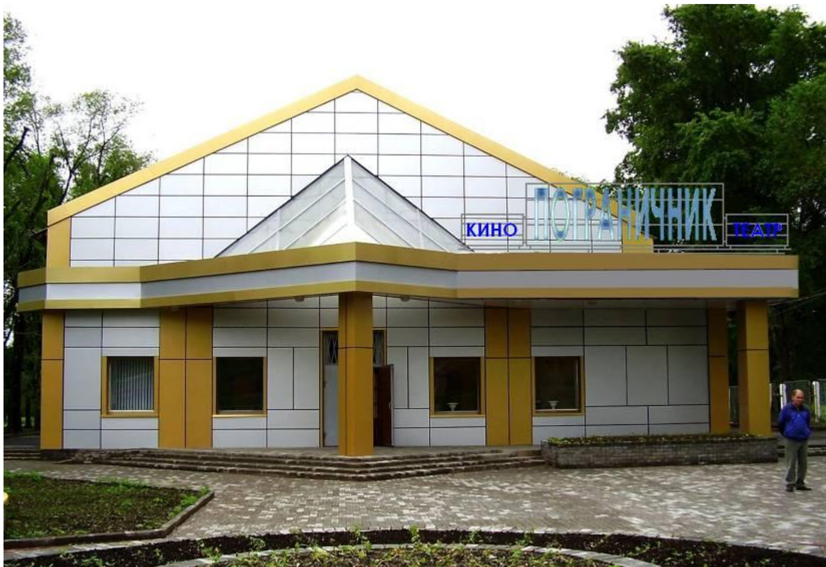
Кинотеатр «Пограничник» после реконструкции
