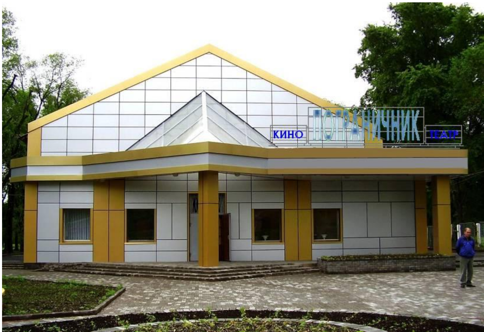
Кинотеатр «Пограничник» после реконструкции
