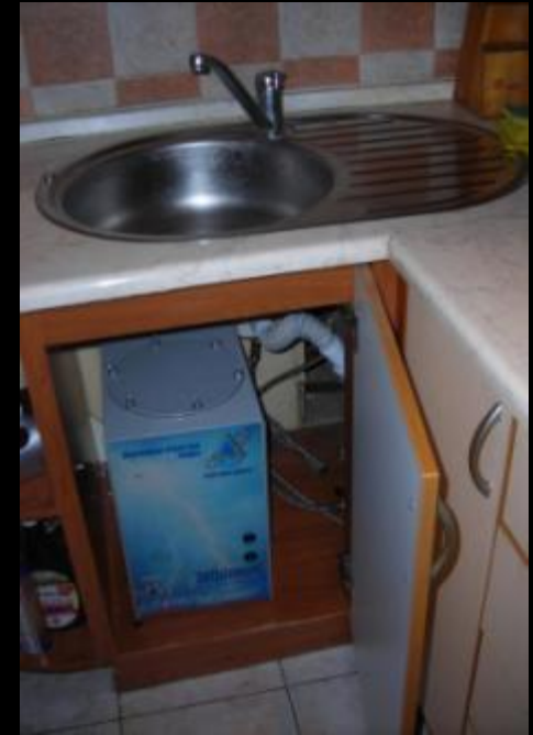
Компактная установка доочистки водопроводной воды серии ЭКОelement под мойку (производительность 3 м 3 /сут)
