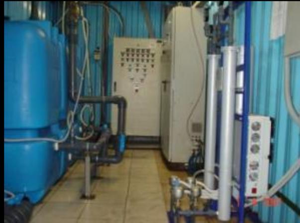
Система озонной очистки воды на линии розлива минеральной воды «Эдельвейс»
