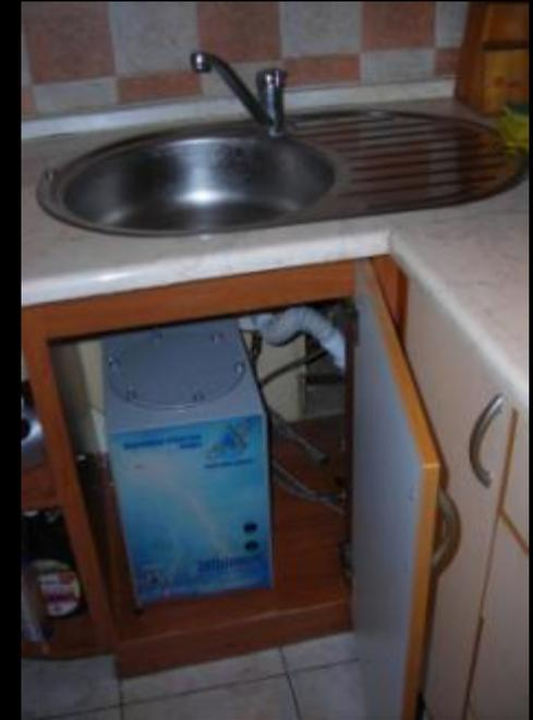
Компактная установка доочистки водопроводной воды серии ЭКОelement под мойку (производительность 3 м<sup>3</sup>/сут)
