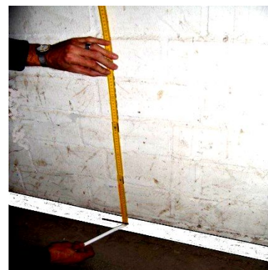
...и отметить высоту на звукоизолирующей кромочной прокладке.
