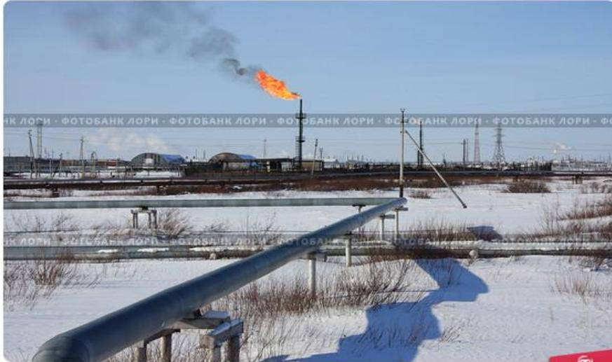
Сжигание попутного газа на харьягинском месторождении нефти
