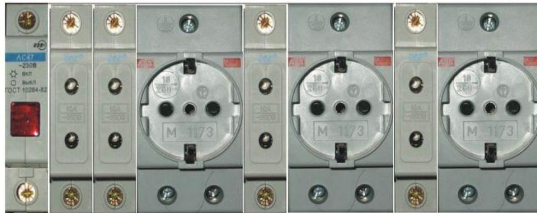
Неуправляемый блок без контроля состояния розеток на 6 розеток (3 полных 3 тонких) в двух группах (2x12) с зуммером, с переключением на резервную возвратную помпу в случае срабатывания УЗО или автомата защиты на основной и автоматическим включением батарейного компрессора при пропадании питания или срабатывания любого УЗО
