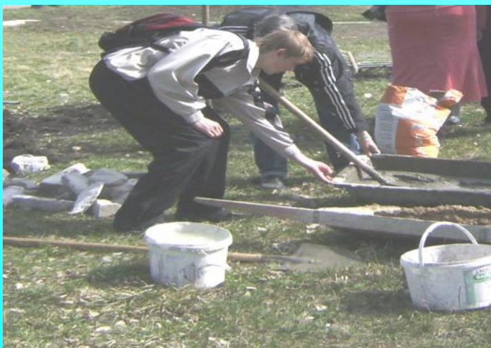
Помощь в устройстве фундамента часовни
