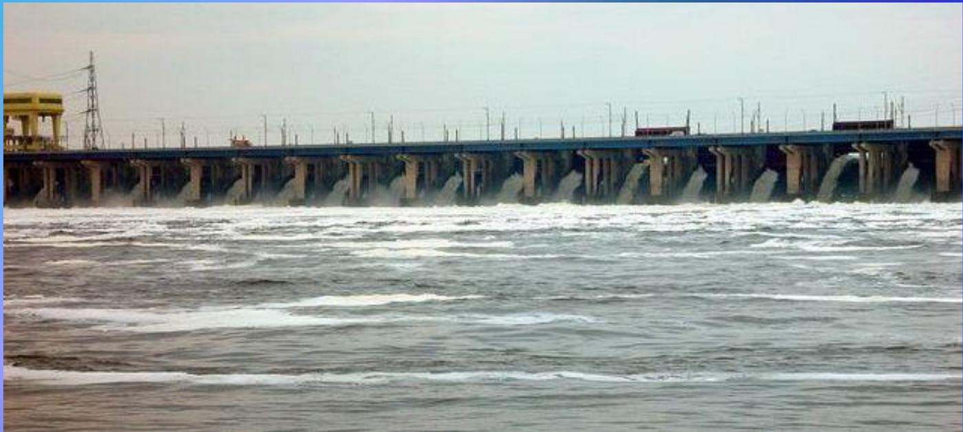
Первая секция от здания ГЭС отведена под рыбоподъемник. Известно, что осетровые и другие породы каспийской рыбы идут нереститься вверх по Волге. Для пропуска рыбы создано специальное автоматизированное сооружение. Для привлечения рыбы в лотках создается течение со скоростью 0,7—1 м в секунду. Рыба, привлекаемая течением, идет против него и накапливается в лотке.
